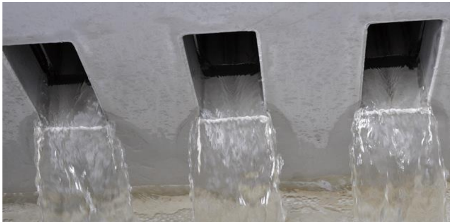
Figure18: traitement tertiaire des eaux usées
