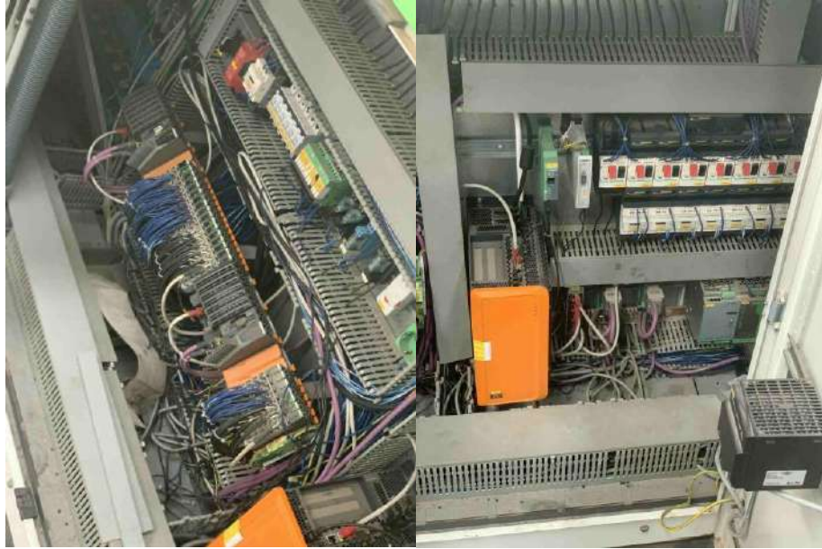
Figure III.13 : Photographie des entrées et sortie de l'extrudeuse de l'ITP d'Oran.
