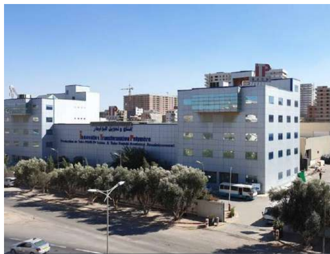
Figure I.1 : Vue générale de L'ITP d'Oran
