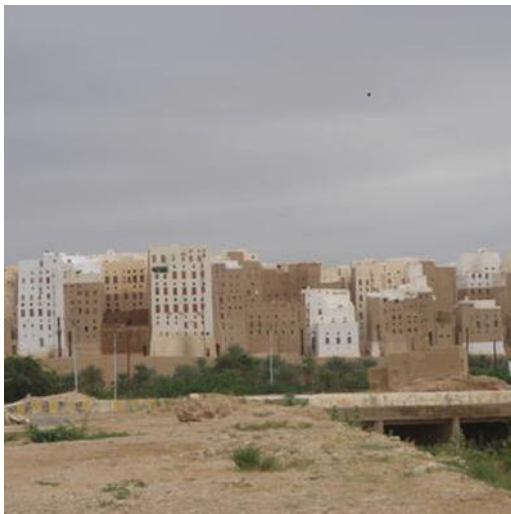
Fig I.1 :Shibām au Yémen
