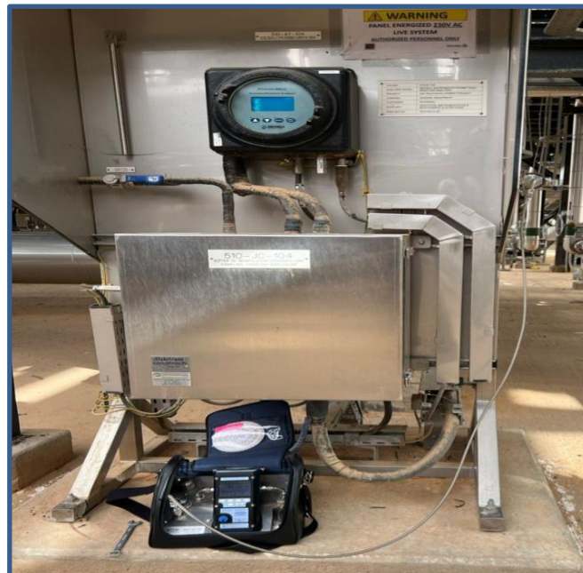
Figure III.15 : Analyseur d'humidité Lié dans la progression de l'installation
