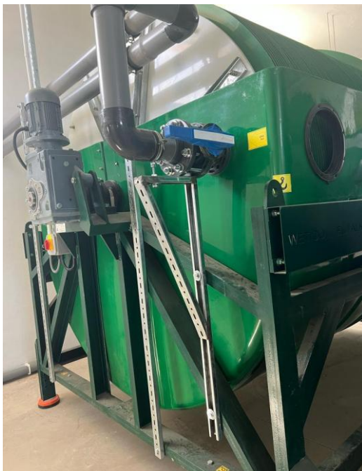
Figure IV. 7: Représente les bios disques de STEP AIN BEIDA
