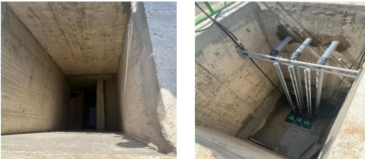
Figure IV.3: Représente un dessablage et un déshuilage
