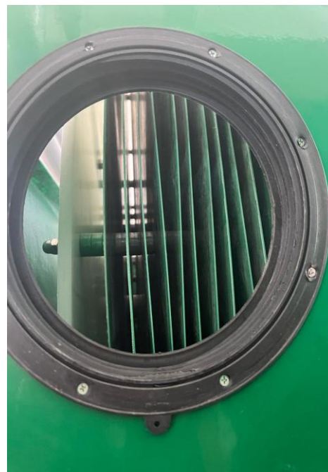
Figure IV. 7: Représente les bios disques de STEP AIN BEIDA
