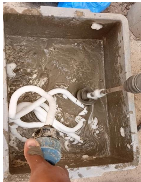
Figure 40 : Incorporation de la mousse
