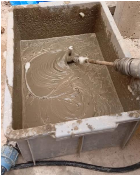
Figure 41 : Préparation du mélange de béton
