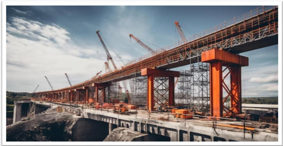
Figure 1.3 : Des travaux de construction.
