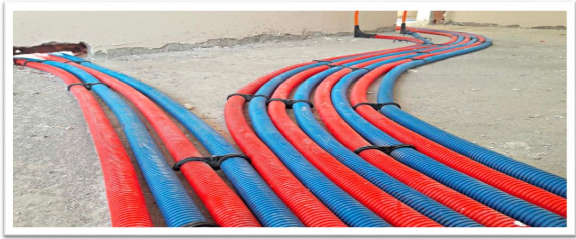
Figure2.12 : Réseau de distribution d'eau dans maison.
