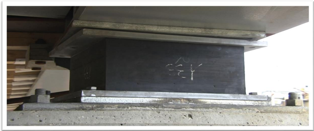
Figure2.11 : Isolation parasismique de la base d'un pont.
