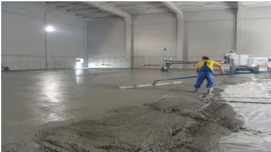
figure-2-3:colage d'une plateforme en béton fibré
