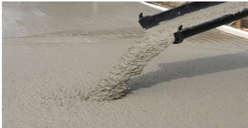
figure-4-2:Visualisation du front de coulée d'un béton
