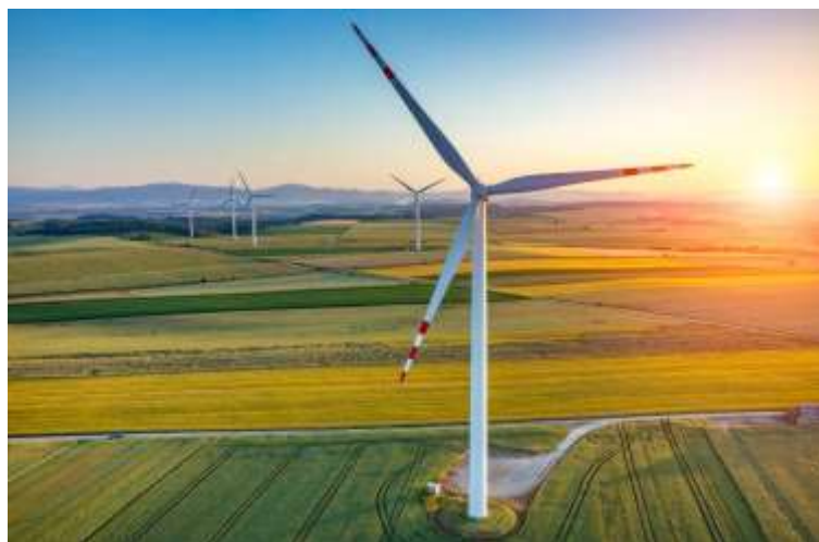
Figure (I.2) : une éolienne[5]
