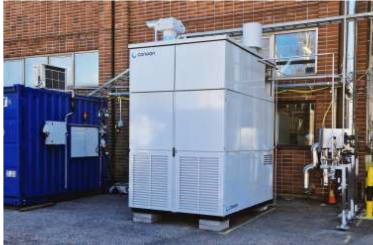
Figure (I.9) : Electrolyseur a oxyde solide SOEC[10]
