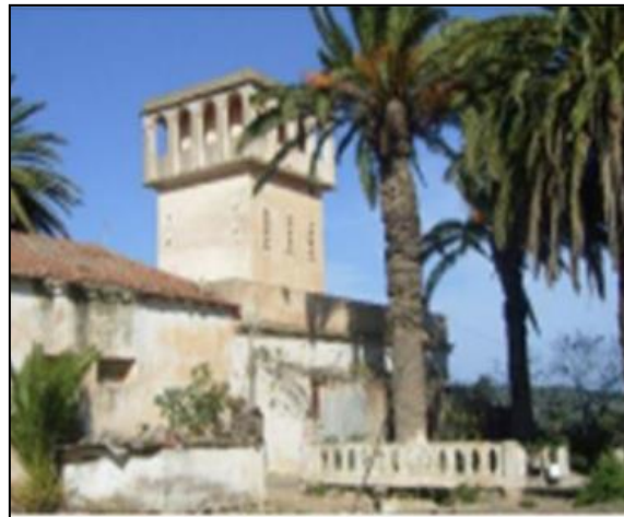
Photographie 40: La Ferme De Pierre Baret
