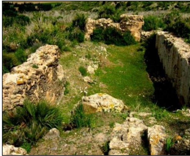
Photographie 46:Le réservoir d'eau 01.
