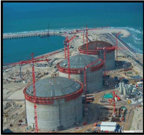
Figure 26 : réservoir en maçonnerie
