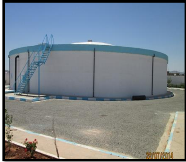
Figure 27 : réservoir en béton armé
