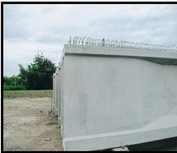
Figure 28 : réservoir en béton précontraint
