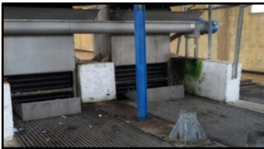
Figure 43 : Grilles fines motorisées [83]
