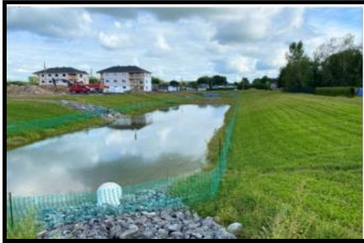
Figure 33 : réservoir de rétention [69]
