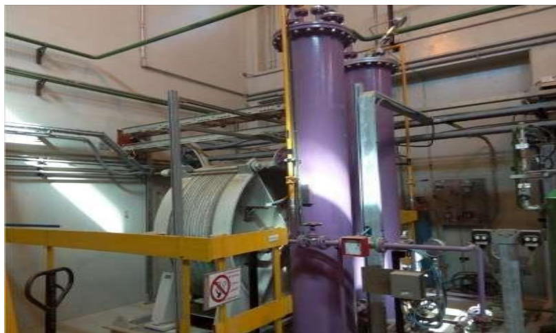
Figure(III.8): Séparateur \text{H}_2 /électrolyte et \text{O}_2
