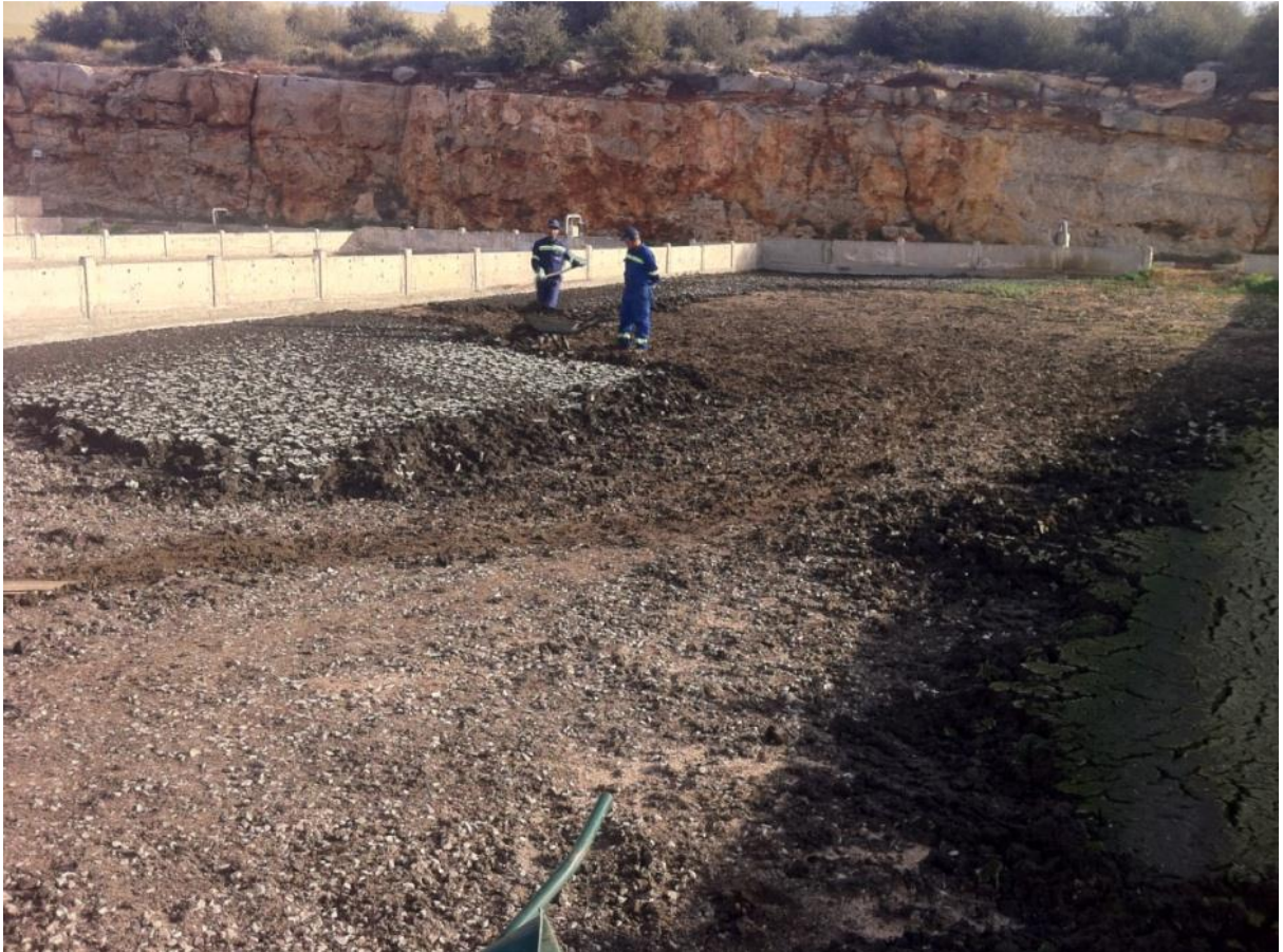
Fig. IV-24 photo d'un lit de séchage endommagé
