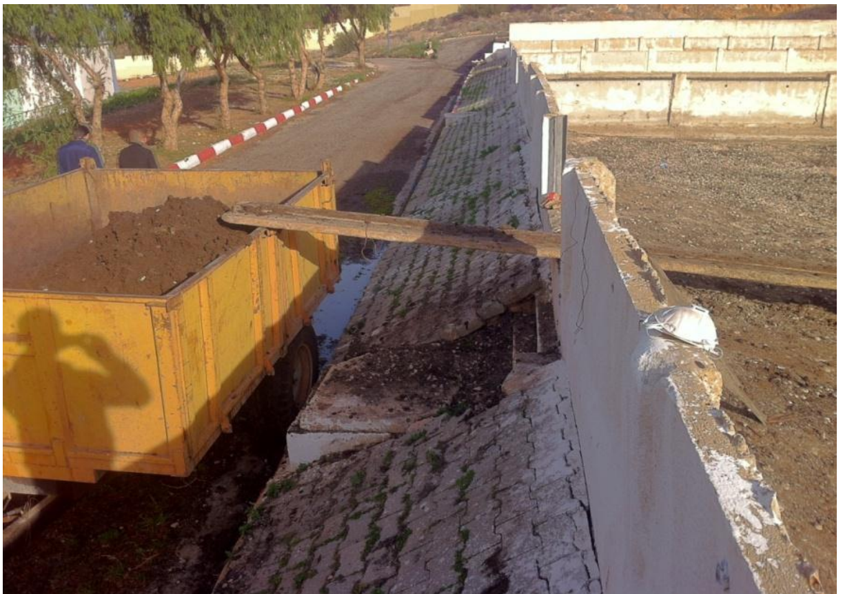
Fig. IV-26 : Système de vidange des lits de séchage
