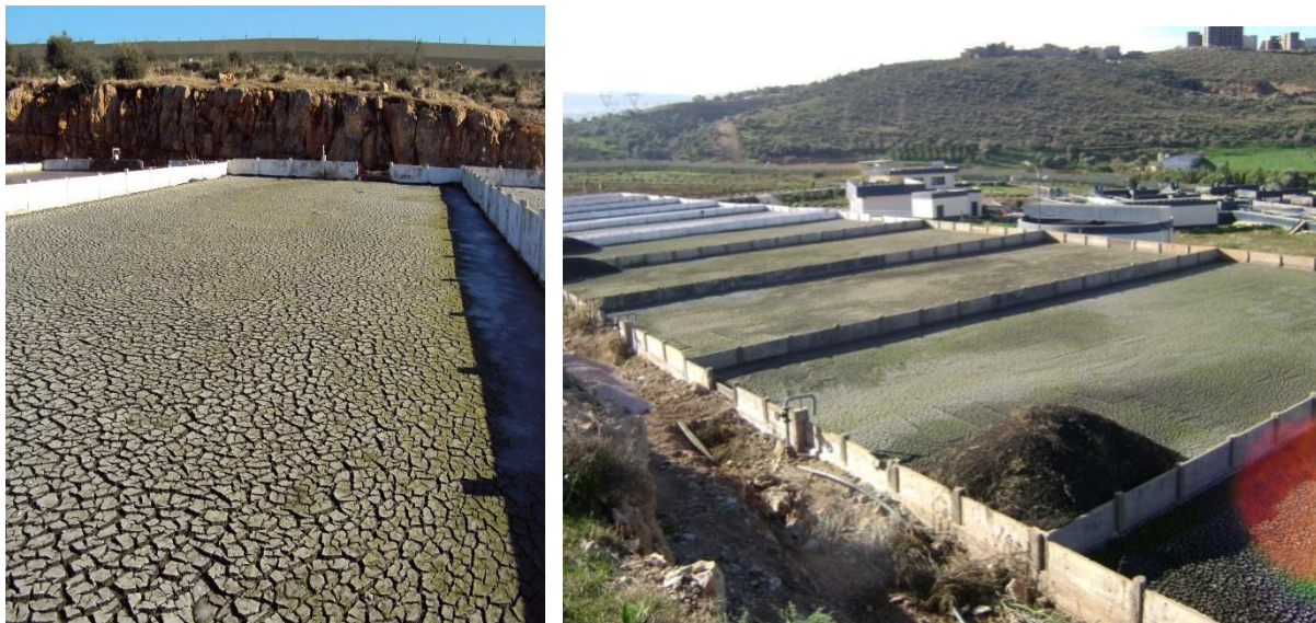
Fig. III-13 photos du lit de séchage [54].
