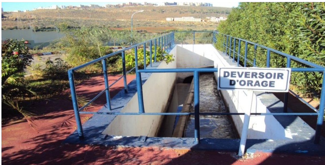
Fig. III-2 photo du déversoir d'orage [54].
