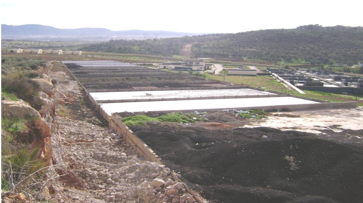
Fig. III-4 photo des lits de séchages + aire de stockage [54]
