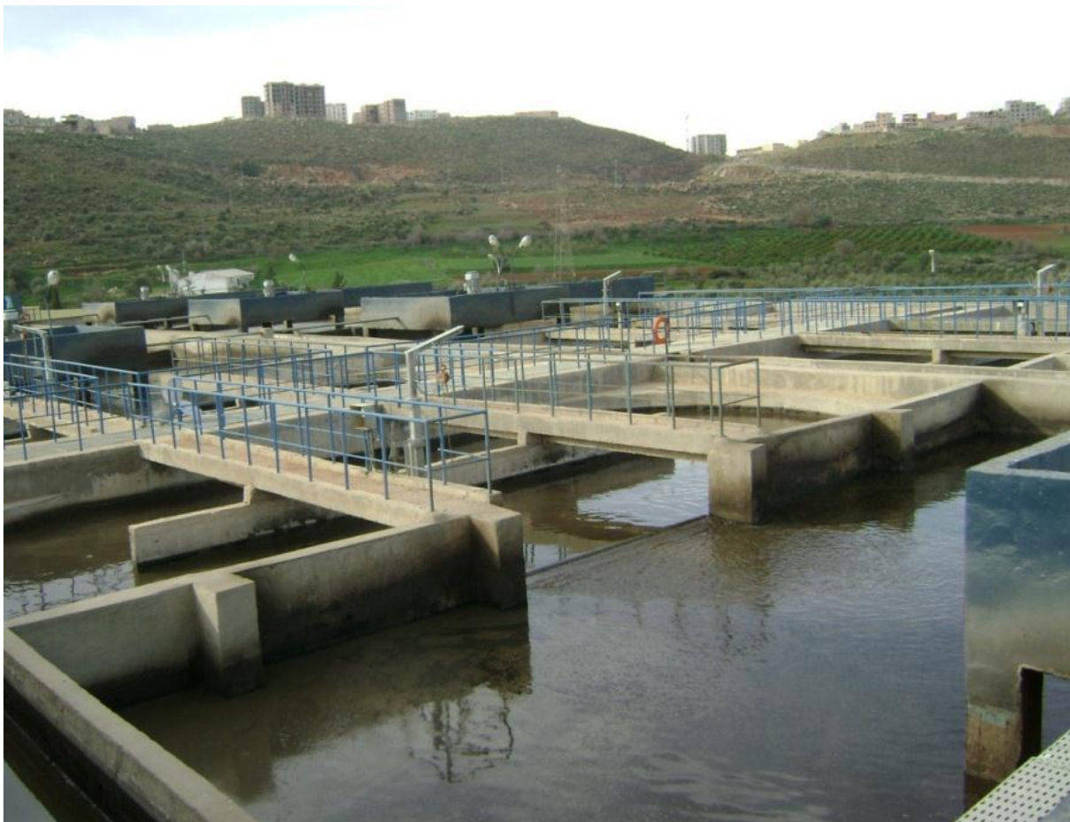
Fig. III-7 Photo du bassin de nitrification dénitrification [54]
