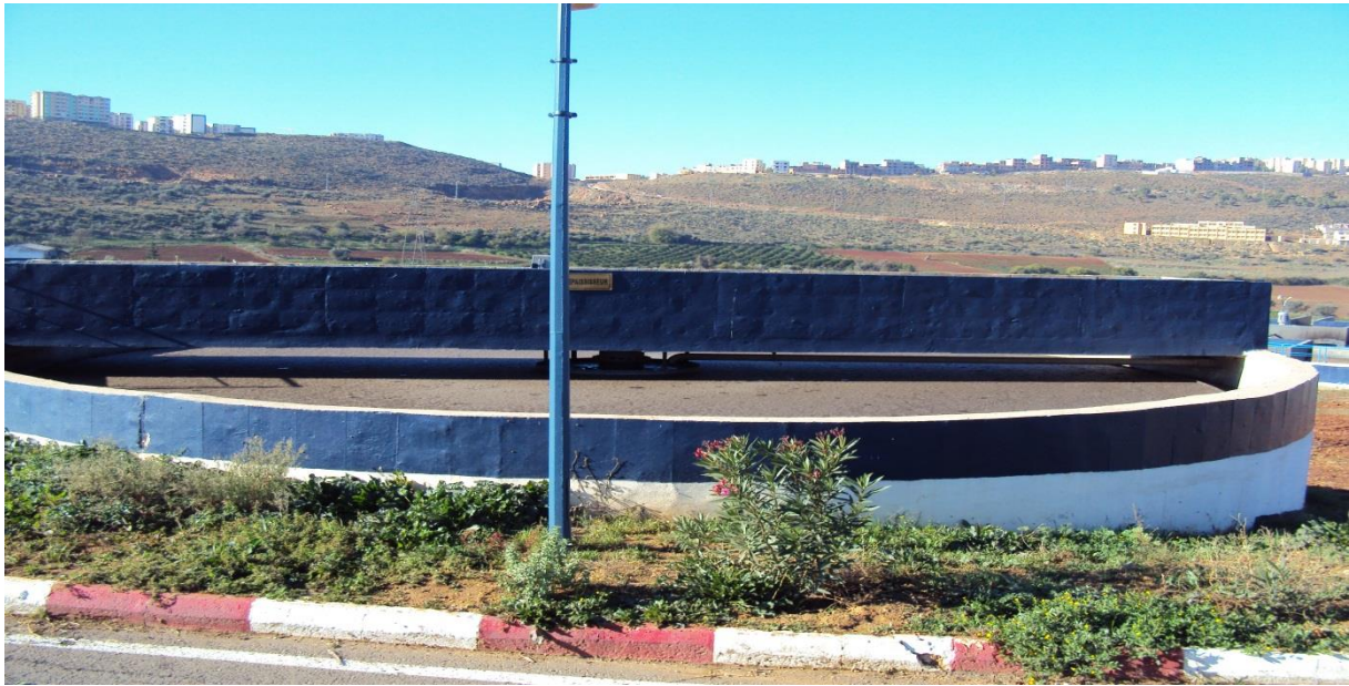
Fig. III-12 photo de l'épaississeur [54]
