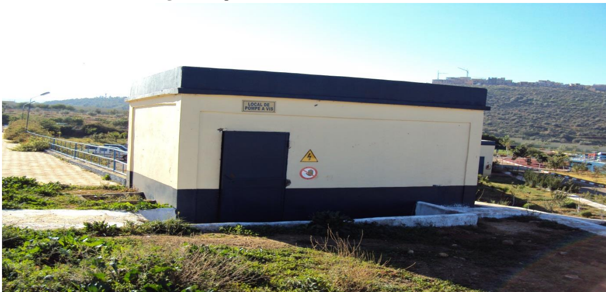
Fig. III-11 photo du local de pompage à vis [54].
