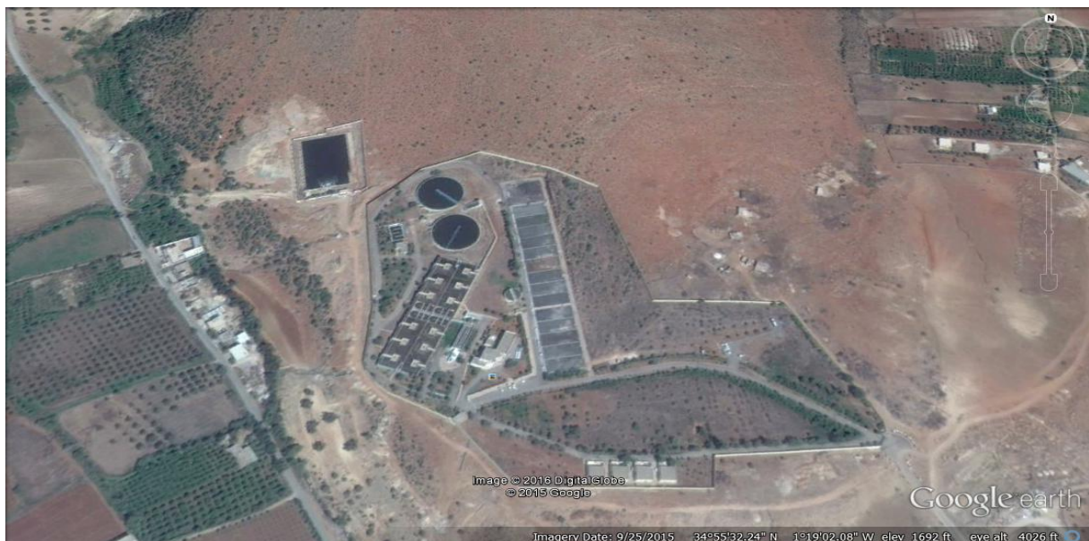
Fig. III-1 photo de la vue de la Station d'épuration d'Ain El Houtz ( www.google.map.com )
