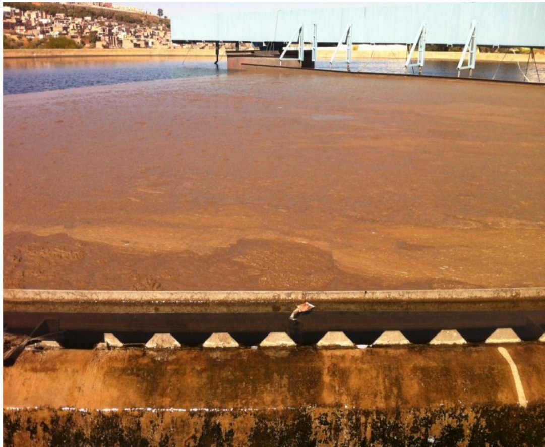
Fig. IV-23 remontée des boues mortes à la surface du clarificateur
