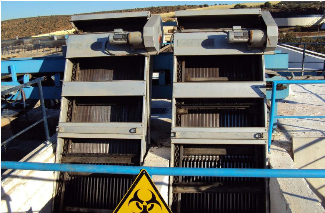
Fig. III-4 photo de la grille mécanisée [54].
