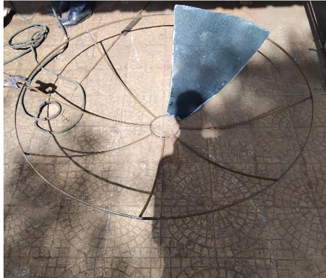
Figure 5.2 : Mise en place des triangles métalliques sur le squelette.
