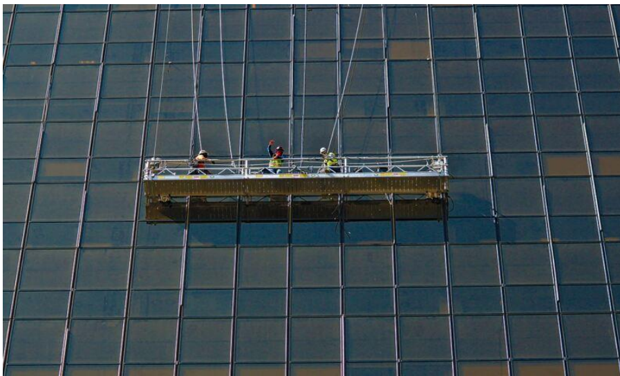
Figure II-14 : nettoyer de la façade vitrée d'un immeuble .
