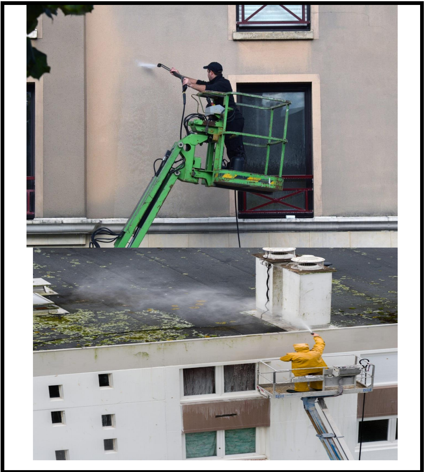
Figure II-7 : la méthode la plus courantes au nettoyages des façades .
