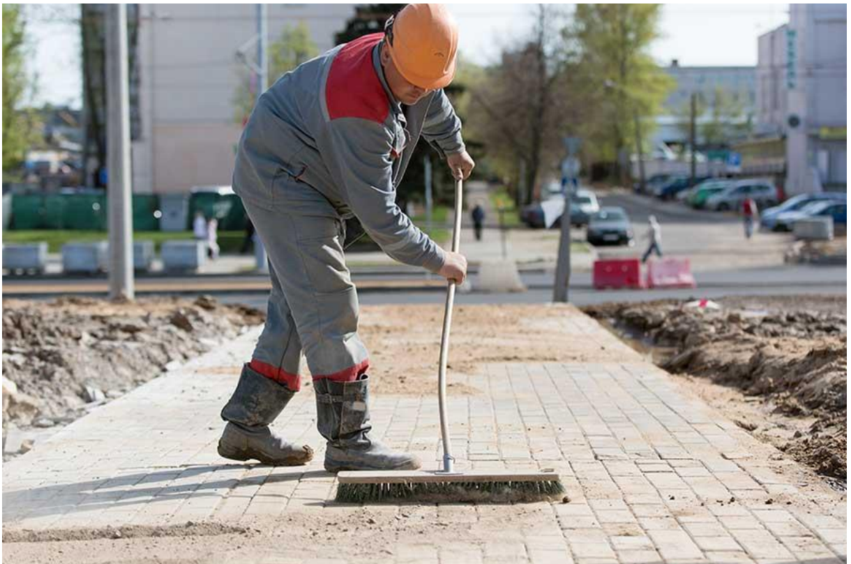
Figure II-12 : nettoyage après chantiers dans la ru .
