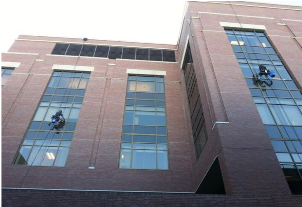
Figure II-16 : nettoyages des vitres avec cordistes .
