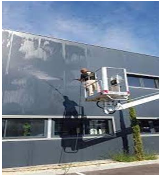
Figure II-15 : nettoyage des façades vitrées avec nacelle
