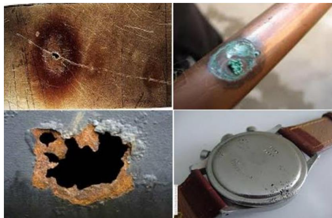
Figure I.4 : Surfaces métalliques affectées par des piqûres
