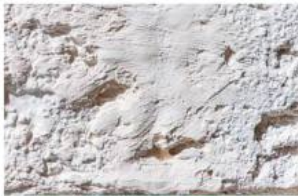
Figure 23: Enduit en plâtre[115]
