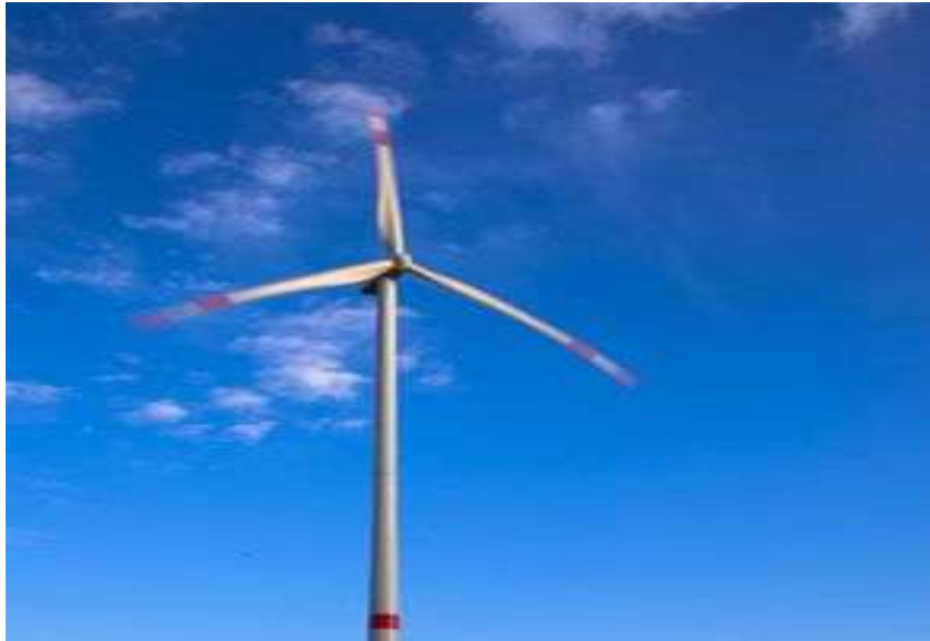
Figure I.13: L'éolienne à axe horizontal.
