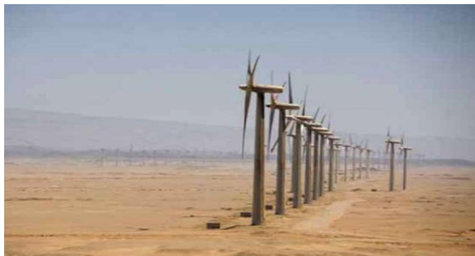
Figure I.11: Ferme éolienne de Kabertene à Adrar.
