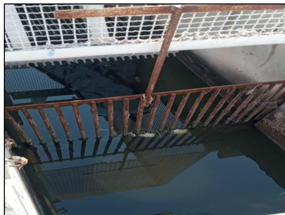
Figure II- 5 : dégrilleur
