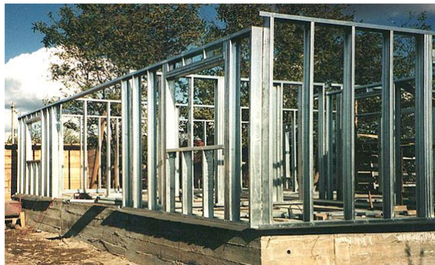
Figure 1.13 : mur à ossature métallique
