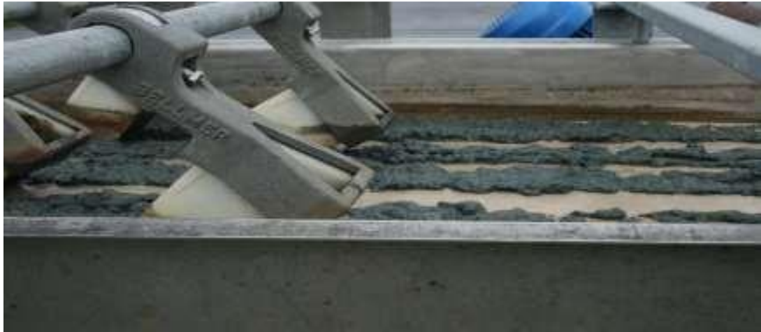
Figure 13 : Déshydratation des boues. [29]
