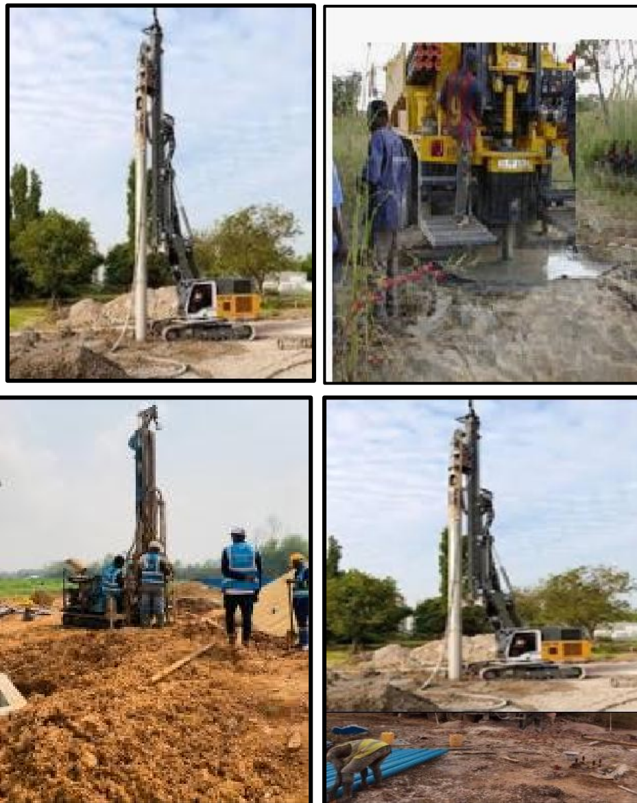
Figure IV.4 : Forage AGHBAL pendant la phase de realisation
