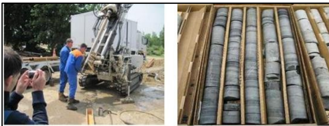
Figure I.3 : technique de forage carotté
