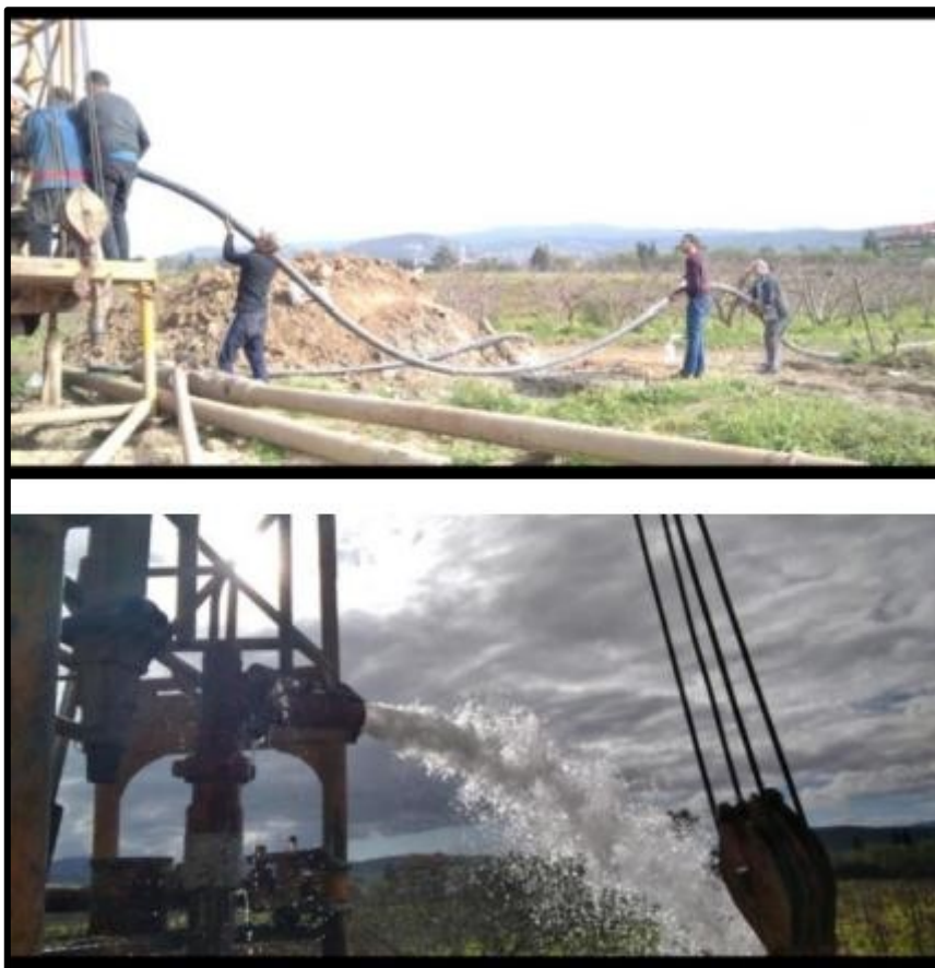
Figure I.16 : Photos d'essai de pompage
