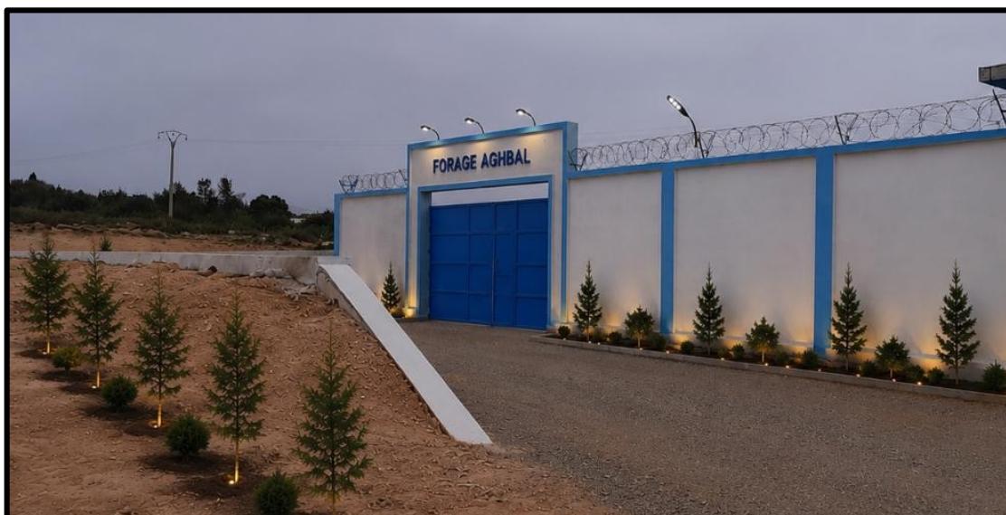
Figure IV.7 : Forage AGHBAL en cours d'exploitation.
