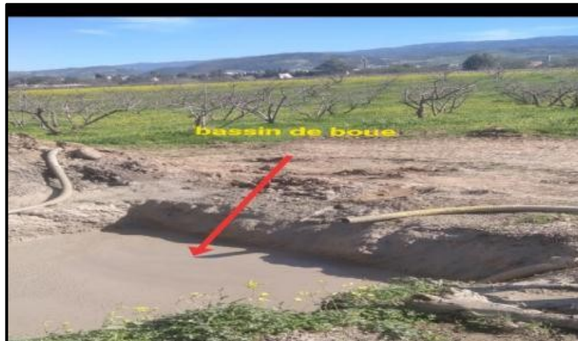
Figure I.11 : photo du bassin de boue
