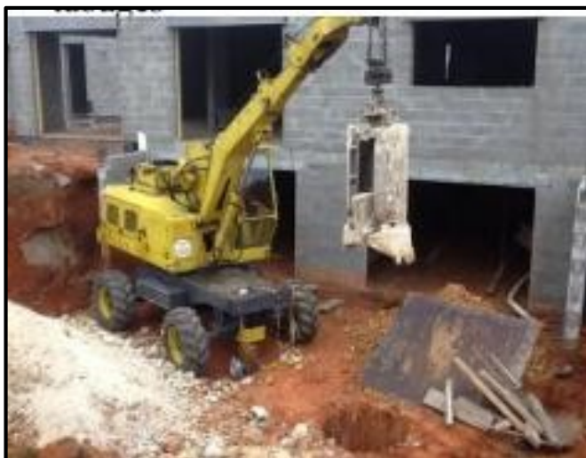
Figure I.10 : Forage par havage
