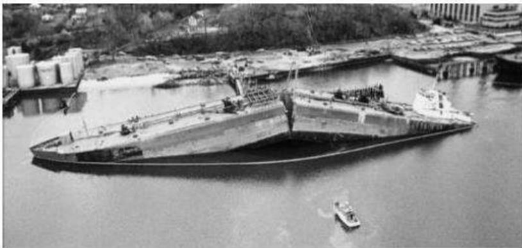
Figure.II. 2: Photographie d'un Liberty ship dont la coque est rompue en deux
