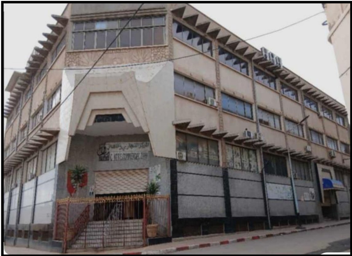
Figure 26: Photographie de le centre commercial Z'Haf, un ancien immeuble colonial réaménagé et réinvesti par des commerçants algériens. (Source : Auteurs. Photographie prise le 22 Mars 2026).
