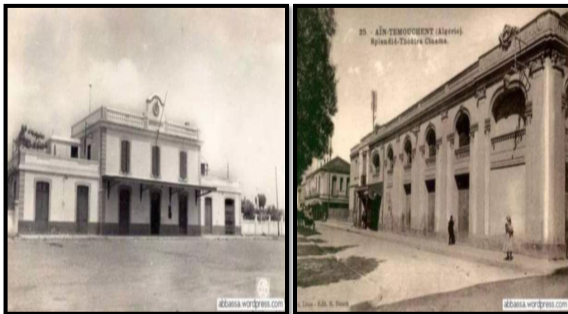
Figure 10: Photographie de la gare et le cinéma à Aïn Témouchent.
