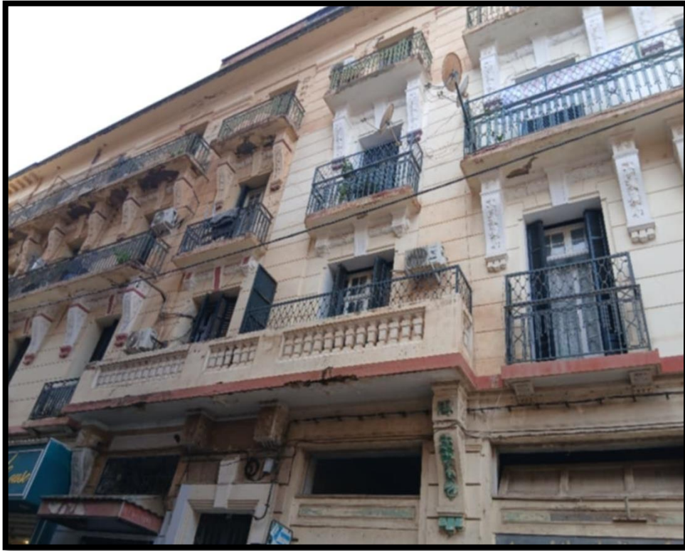
Figure 23 : Photographie d'Immeuble résidentiel colonial à Aïn Témouchent
