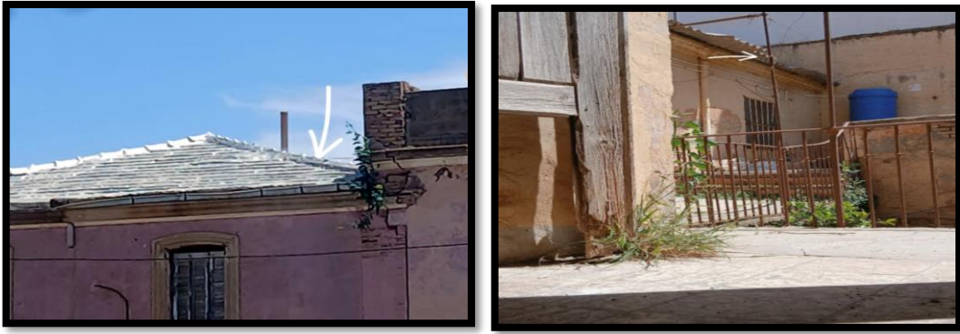
Figure 48 : Photographie derajout d'une couverture en tôle (Source: Auteures. Photographie prise le 13 mai 2026)
