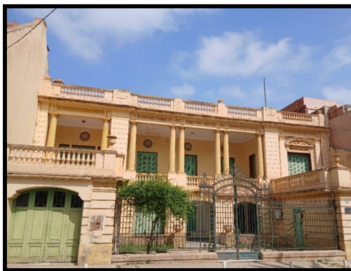
Figure 15 : Photographie d'habitat Individuelle Quartier El Mizane.
