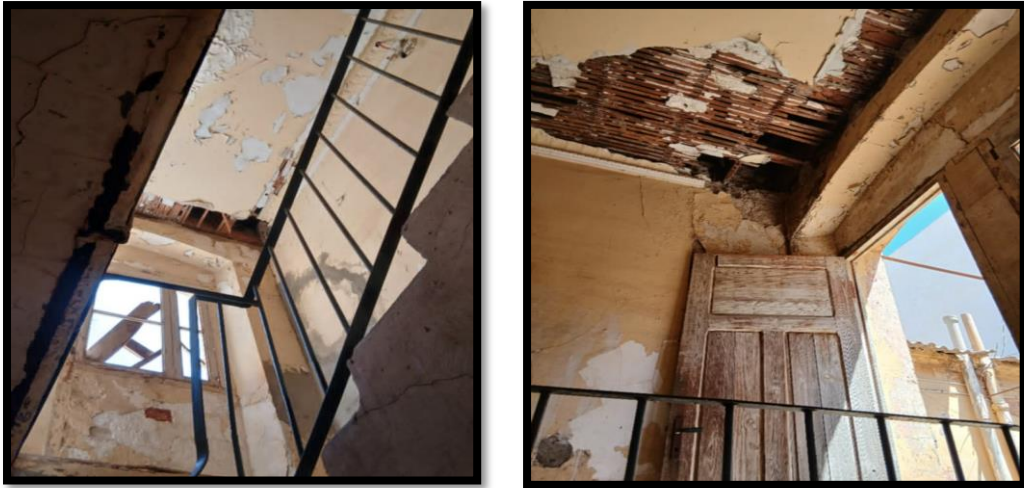
Figure 52 : Photographie de plafond de la cage d'escalier.
