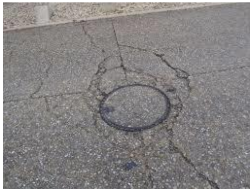
Figure 41: Dénivellation des regards et puisards [5].
