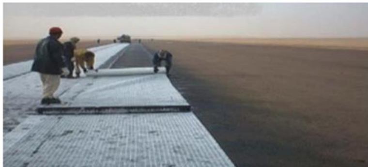
Figure 48 : Emplacement de la nappe gorille
