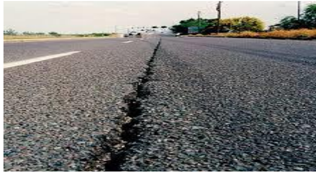
Figure 26: Fissures longitudinales [5].
