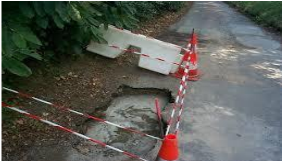
Figure 39: Remontées d'eau [5].
