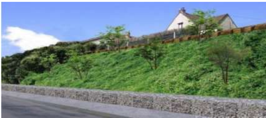
Figure 2.10 : L'implantation des plantes dans un talus
