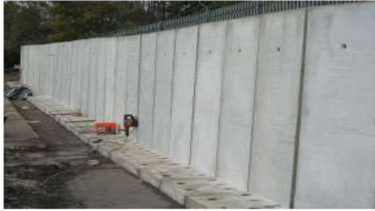
Figure 2.20: Mur en bétonarmé préfabriqué (Youcef tani. & ramdani., 2021)
