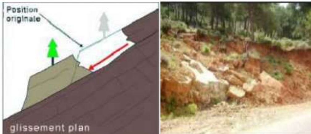
Figure 1.13 : Glissement plans . (Bouhchicha. & Doudou., pfe 2022. )
