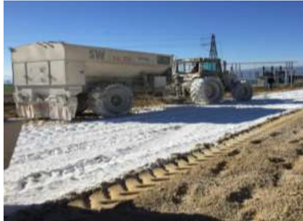
Figure 2.24 : Traitements du sol avec poudre de verre www.altas.nrcan
