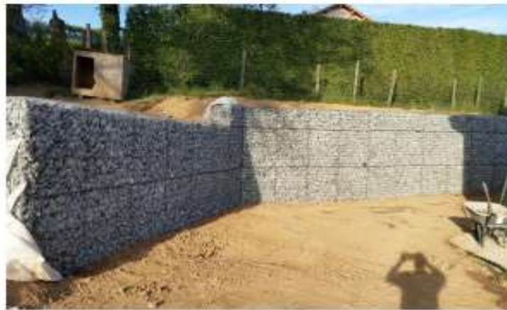
Figure 2.22 : Réalisation en mur en gabion (Youcef tani. & ramdani., 2021)
