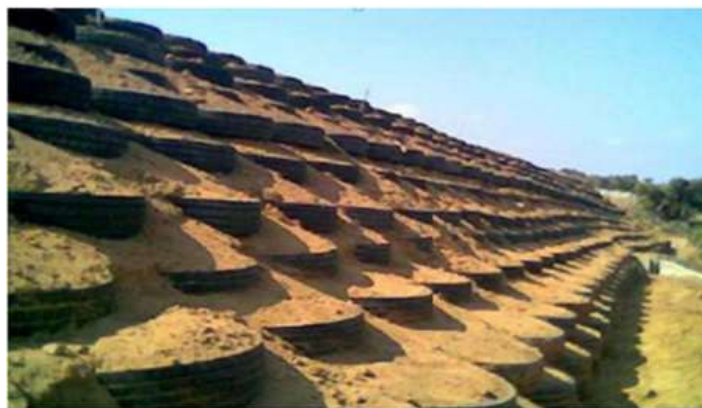
Figure 2.14 : Chantier moutiers-mur expérimental pneu sol à bou-smail.
