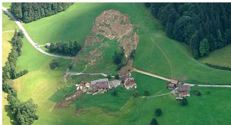
Figure 1.17 : exemple d'un glissement profond (suisse)
