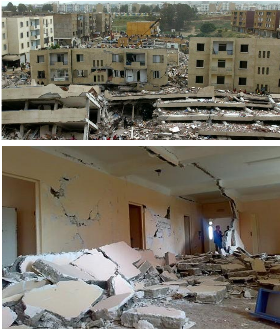
Figure 1.4. Effets du séisme de Boumerdès
