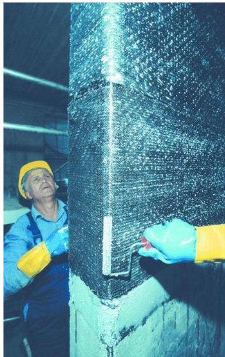
Figure 2.1. Modèle de collage de fibre de carbone sur un élément en béton armé
