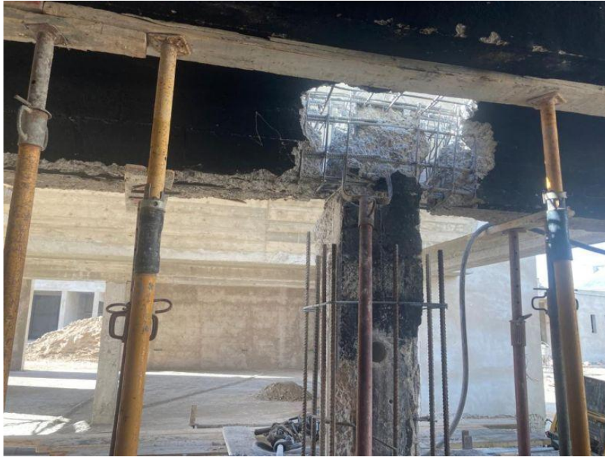
Figure 2.4. Renforcement d'un poteau par chemisage en béton armé
