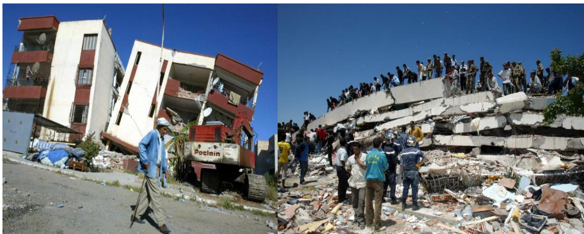
Figure I.2. Dommages importants causés au parc bâti lors du séisme dans Algérie
