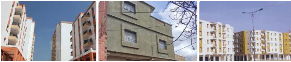
Figure 1.12. Immeubles en béton armé de type R+4 à R+8 à Sidi Bel Abbès. (constructions, réalisées majoritairement avant les révisions récentes des normes parasismiques, présentent une vulnérabilité accrue face aux sollicitations sismiques).
