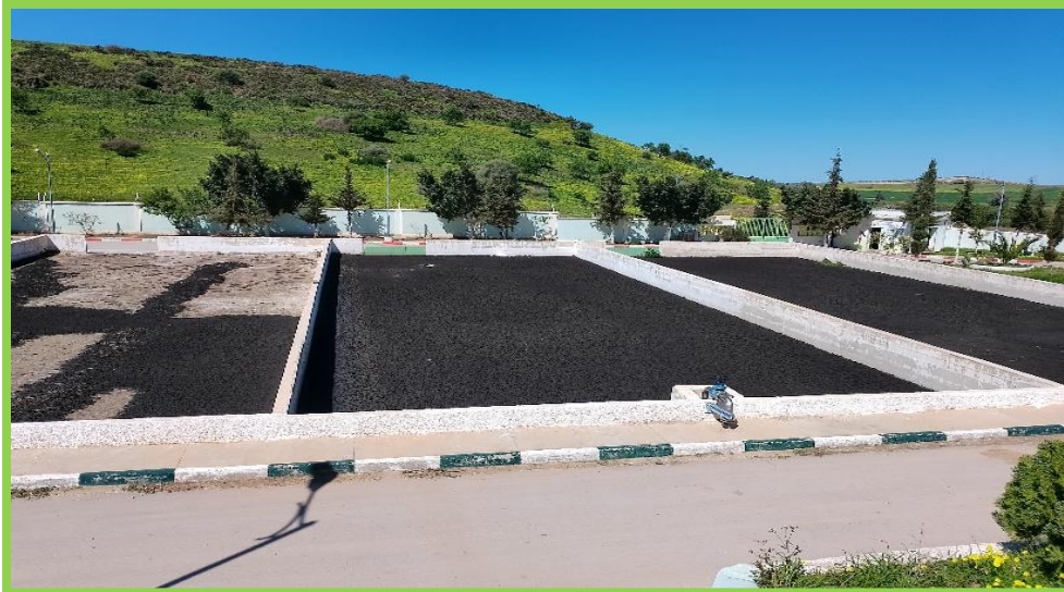
Figure 20:lits de séchage
