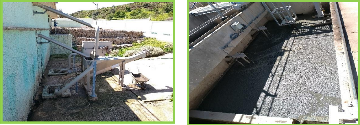
Figure 14 :Dessablage et déshuilage
