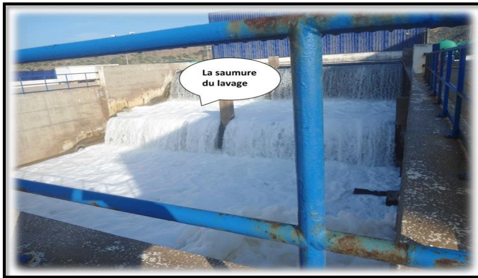
Figure 28 : Eau de Lavage à la saumure (Backwash) (BWC)
