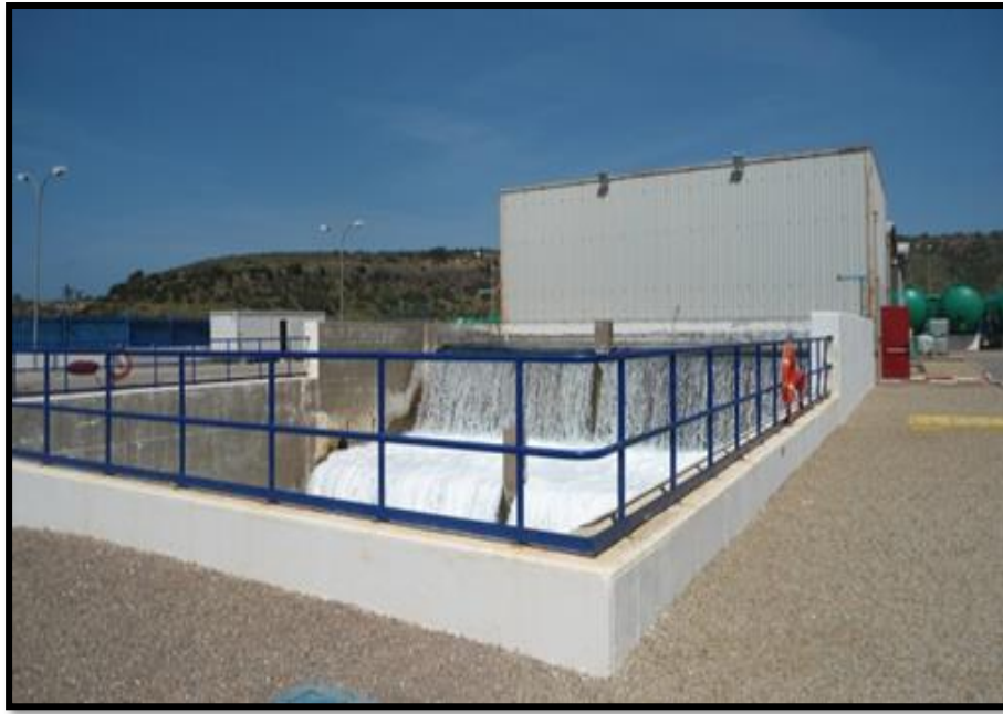
Figure 29 : Bâtiment de saumure (BWC)
