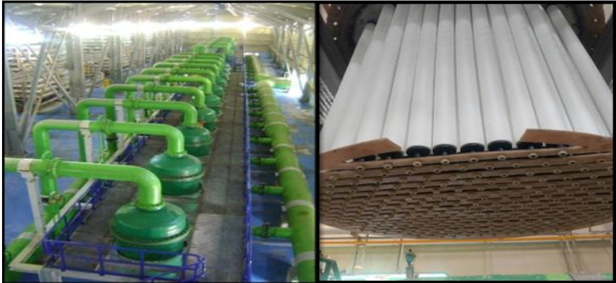
Figure 21 : les filtres à cartouches (BWC)
