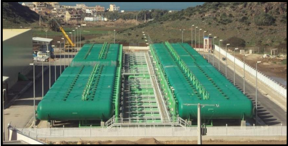
Figure 20 : zone des filtres à sable et à anthracite de la SDEM de Béni Saf (BWC)
