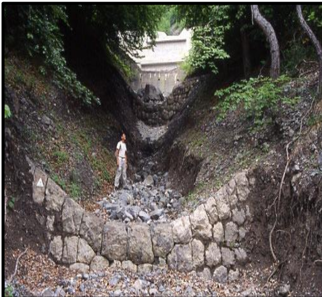
Figure 44: Succession de seuils en pierres sèches (irma)
