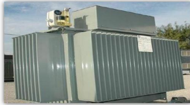
Figure1.13: La cuve d'un transformateur de puissance [3]
