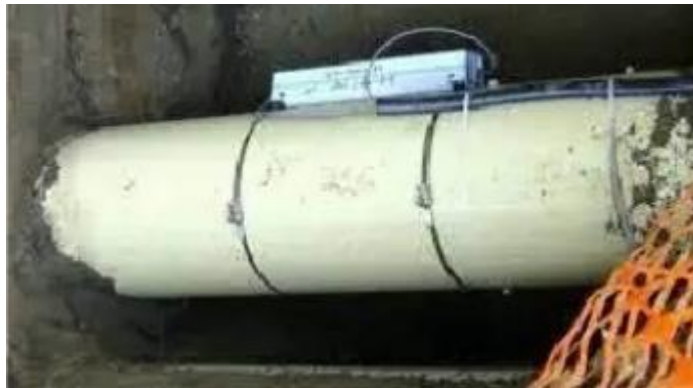
Figure II.50: Système de détection des fuites.
