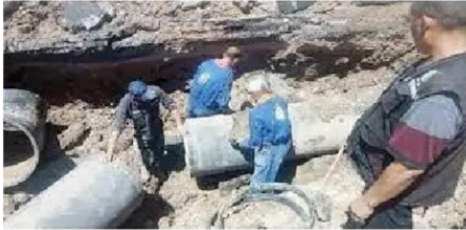
Figure II.48: La réhabilitation du réseau.
