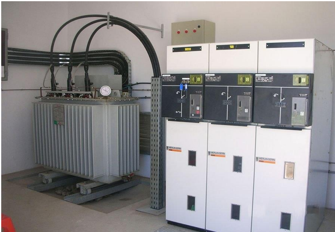
Figure I.9 : Poste de transformateur [62]
