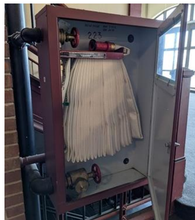
Figure 19 Colonne montante de classe III. [15]
