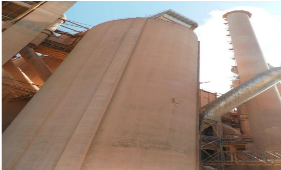
Figure I.7. Silos d'homogénéisation. [15]
