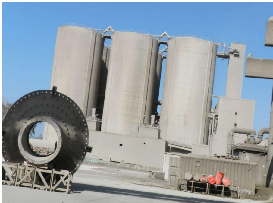
Figure I.12. Silos de stockage de ciment. [15]
