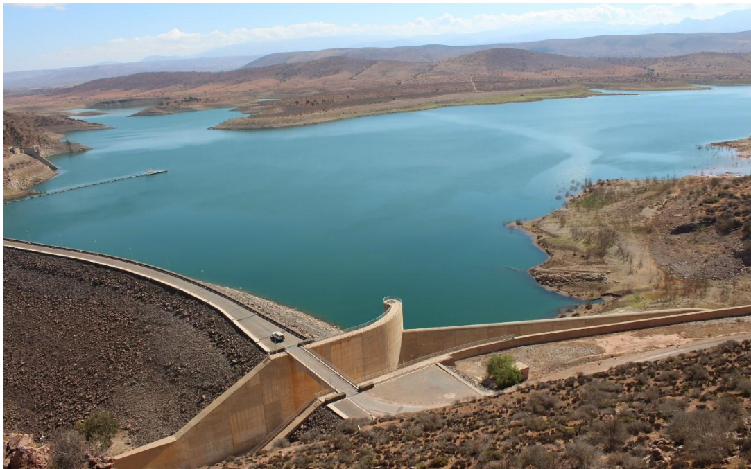
Fig.2.4. Barrage d'El Mansour Eddahbi (Maroc).
