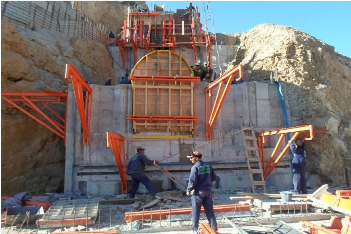
Fig.3.2. Barrage en cours d'exécution
