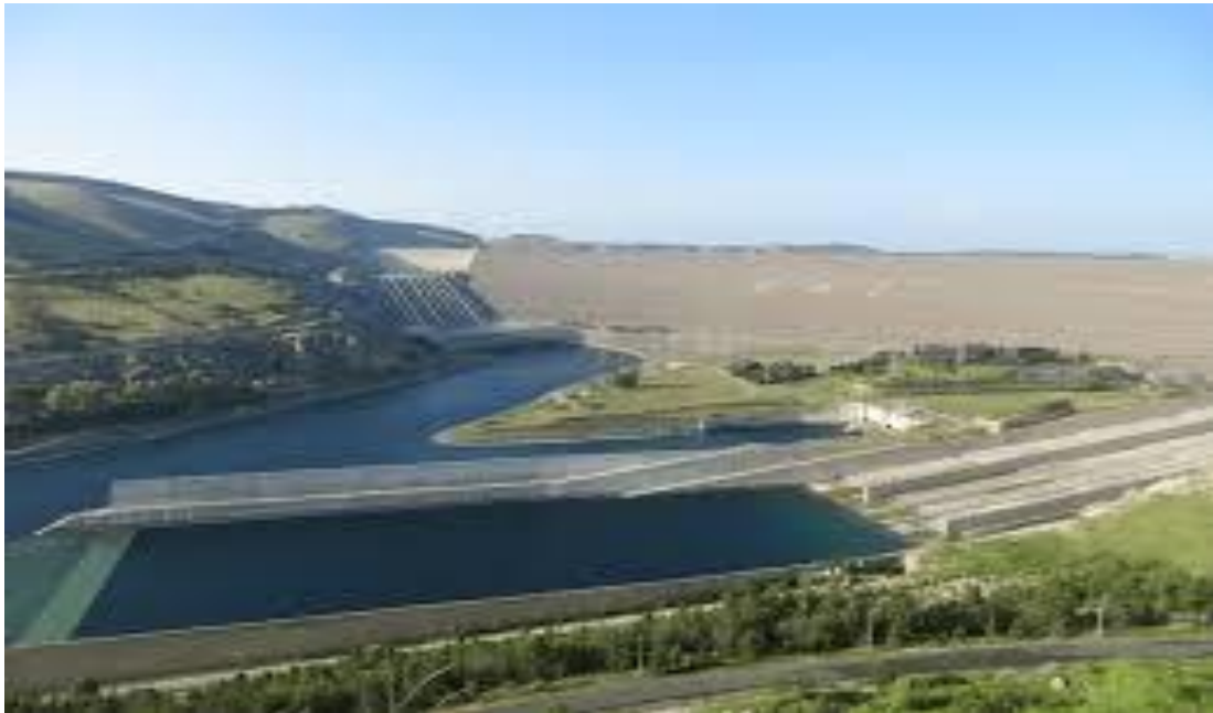
fig.2.11. Barrage de Keban (Turquie).
