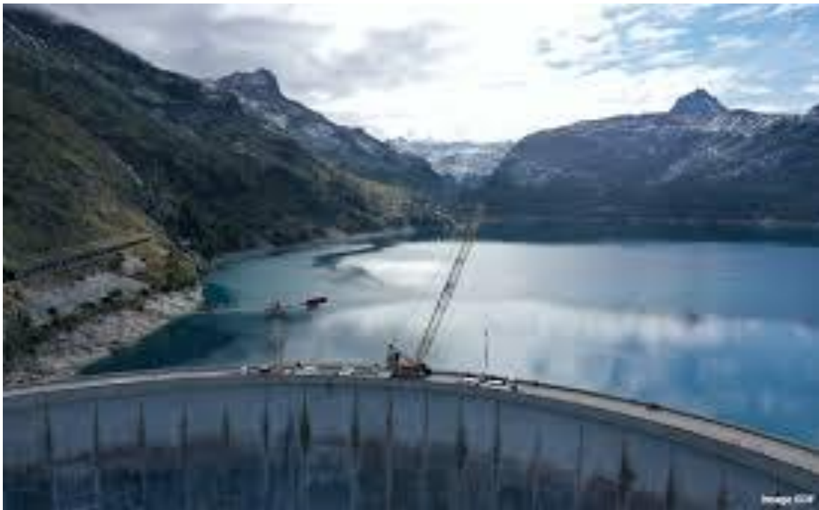
Fig.2.5. Barrage de Tignes (France).
