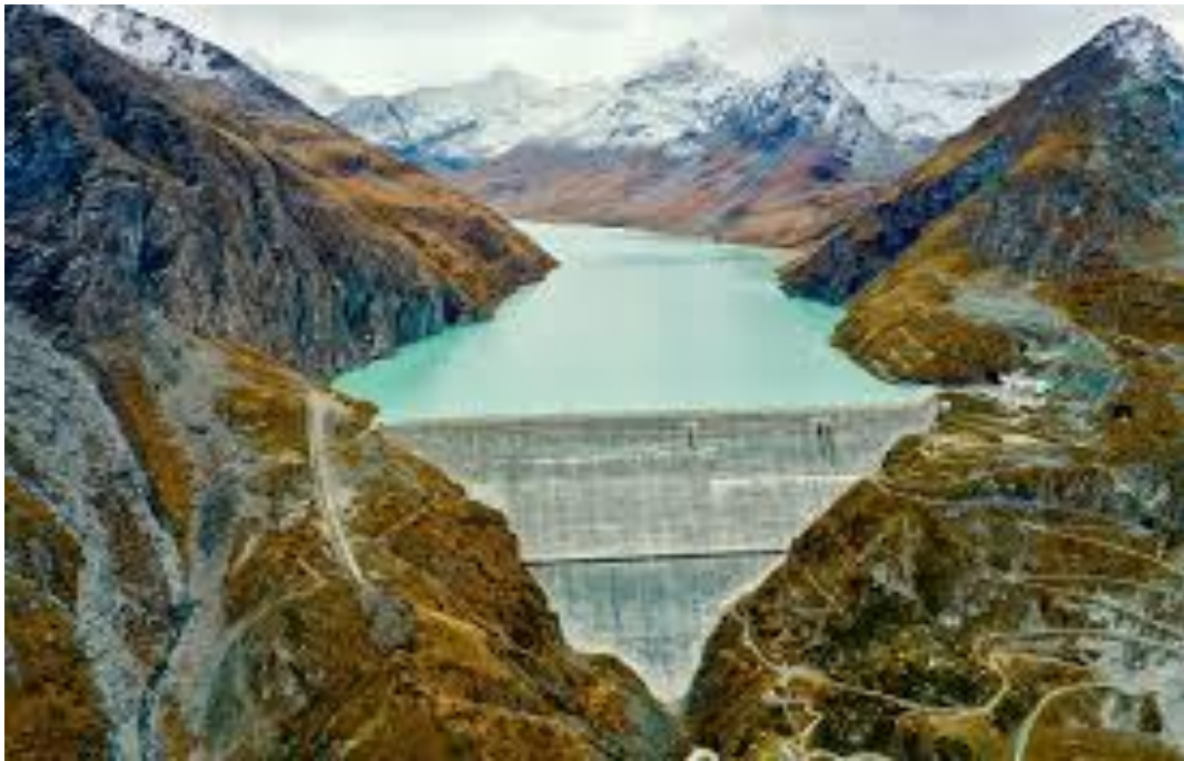
Fig.2.3. Barrage de Grand Dixence (Suisse).
