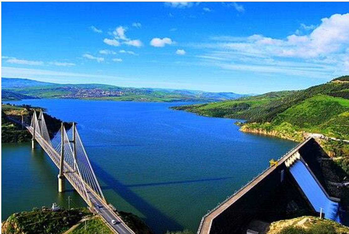
Fig.2.8. Vue du barrage de Beni Haroun.
