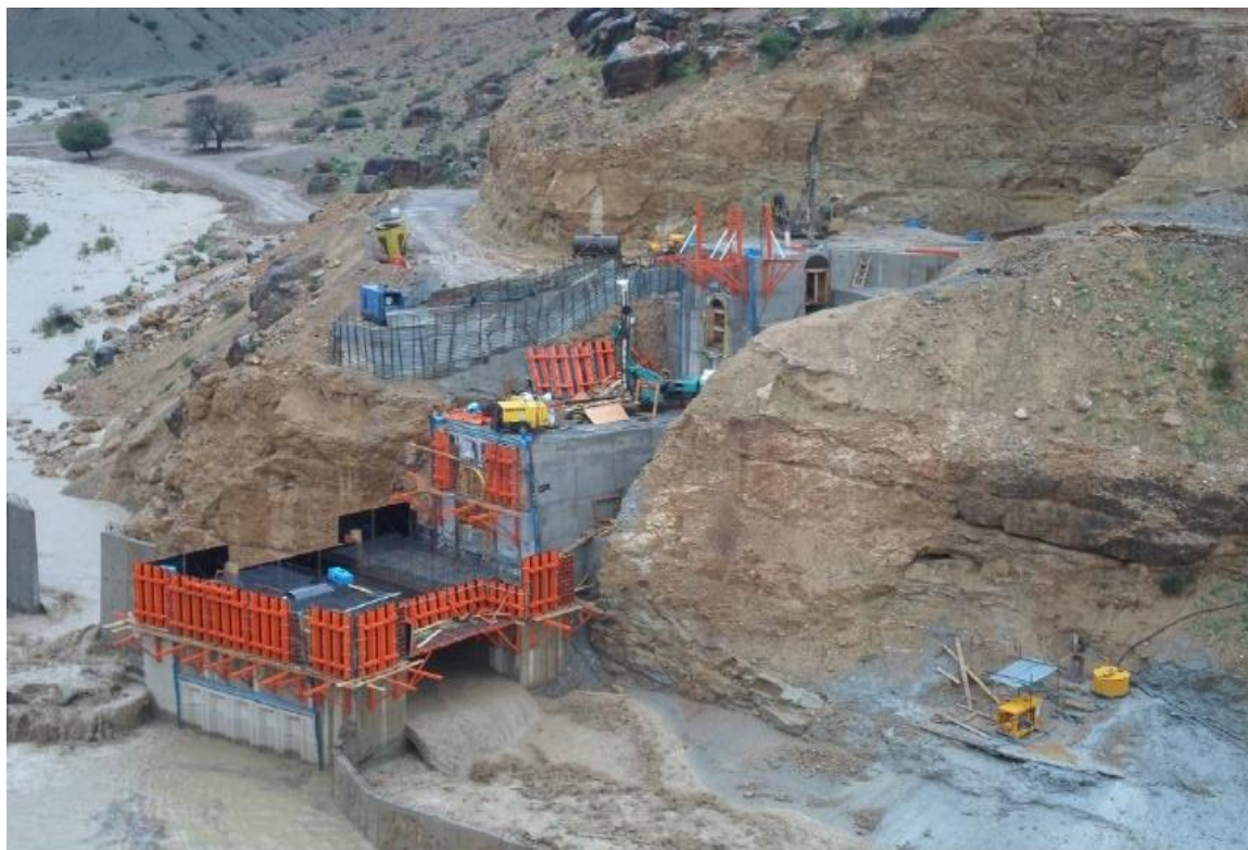
Figure 3.3. Exécution des travaux
