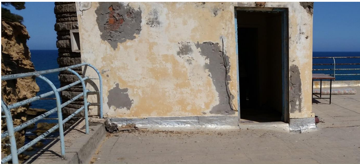
Figure 5-12 : Cage d'escalier à la terrasse.
