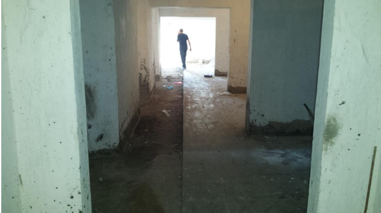
Figure 5-42 : Chape du béton posée
