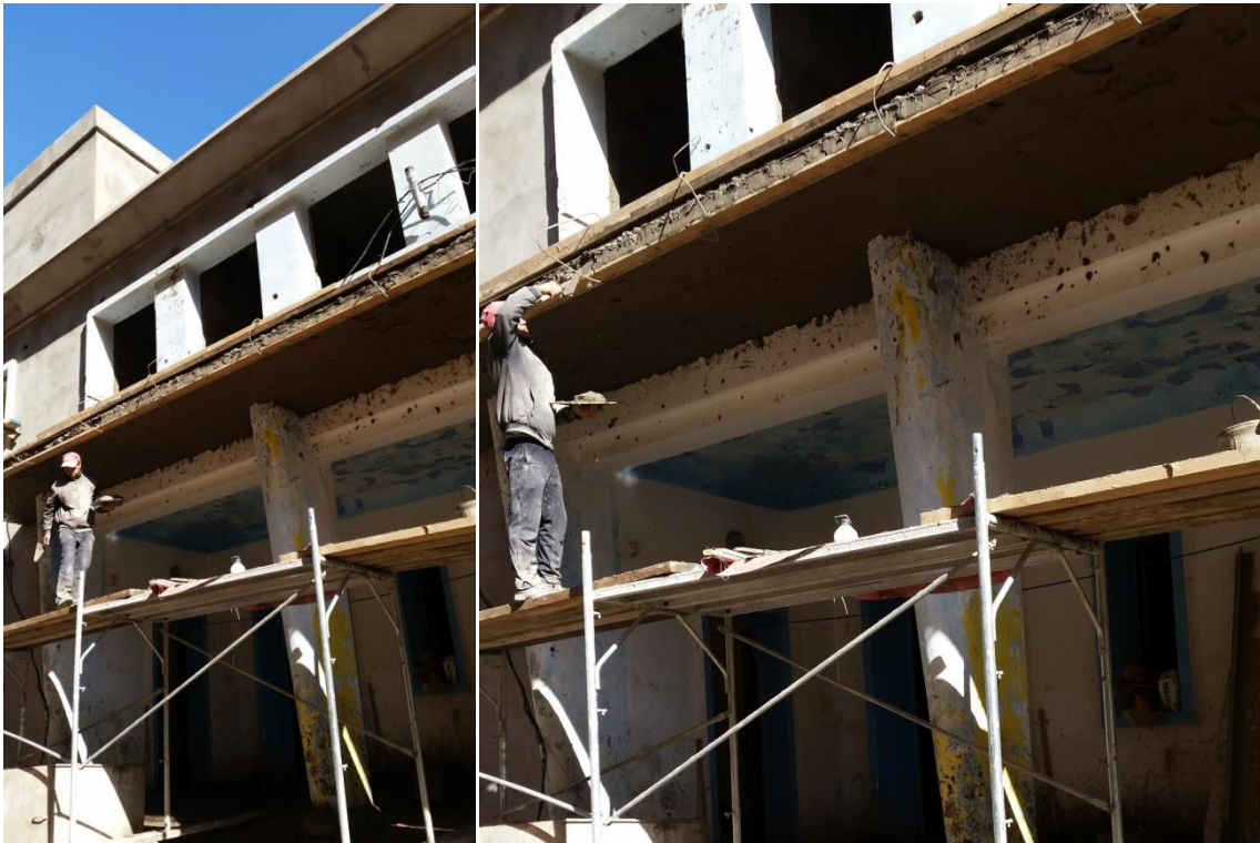
Figure 5-26 : Réparation du béton dégradé
