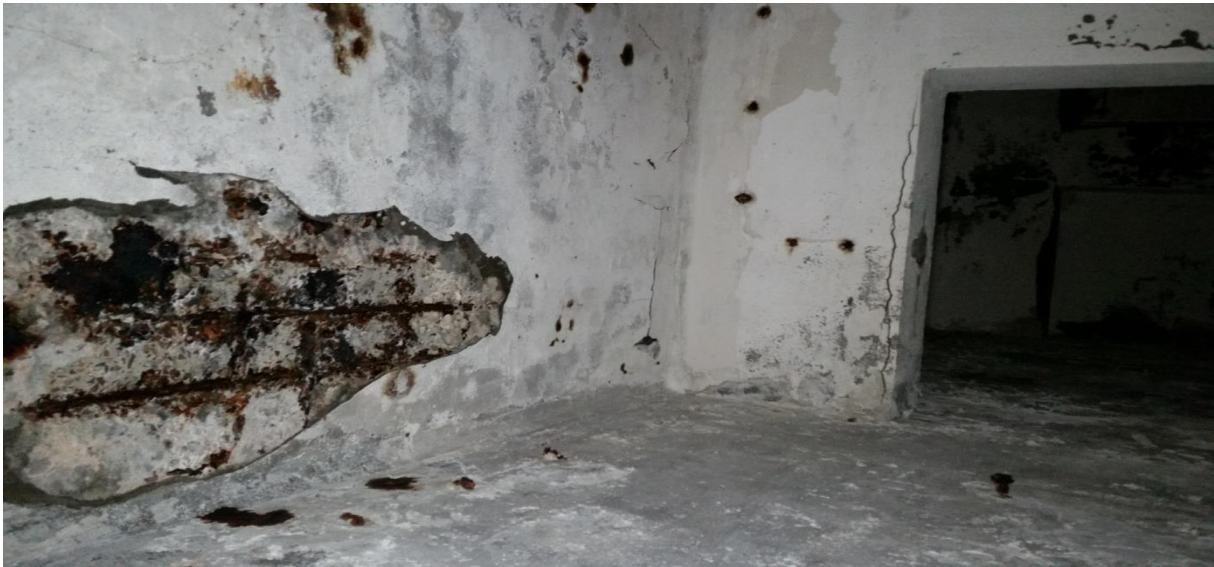
Figure 5-19 : Mur à l'intérieur.
