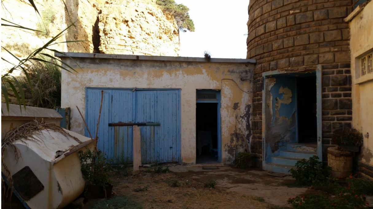
Figure 5-11: L'entrée de château d'eau
