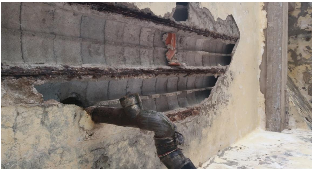
Figure 5-14 : Mur à l'intérieur.
