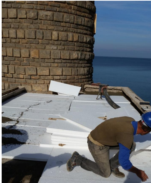
Figure 5-32 : Pose de feuille de polystyrène sur terrasse
