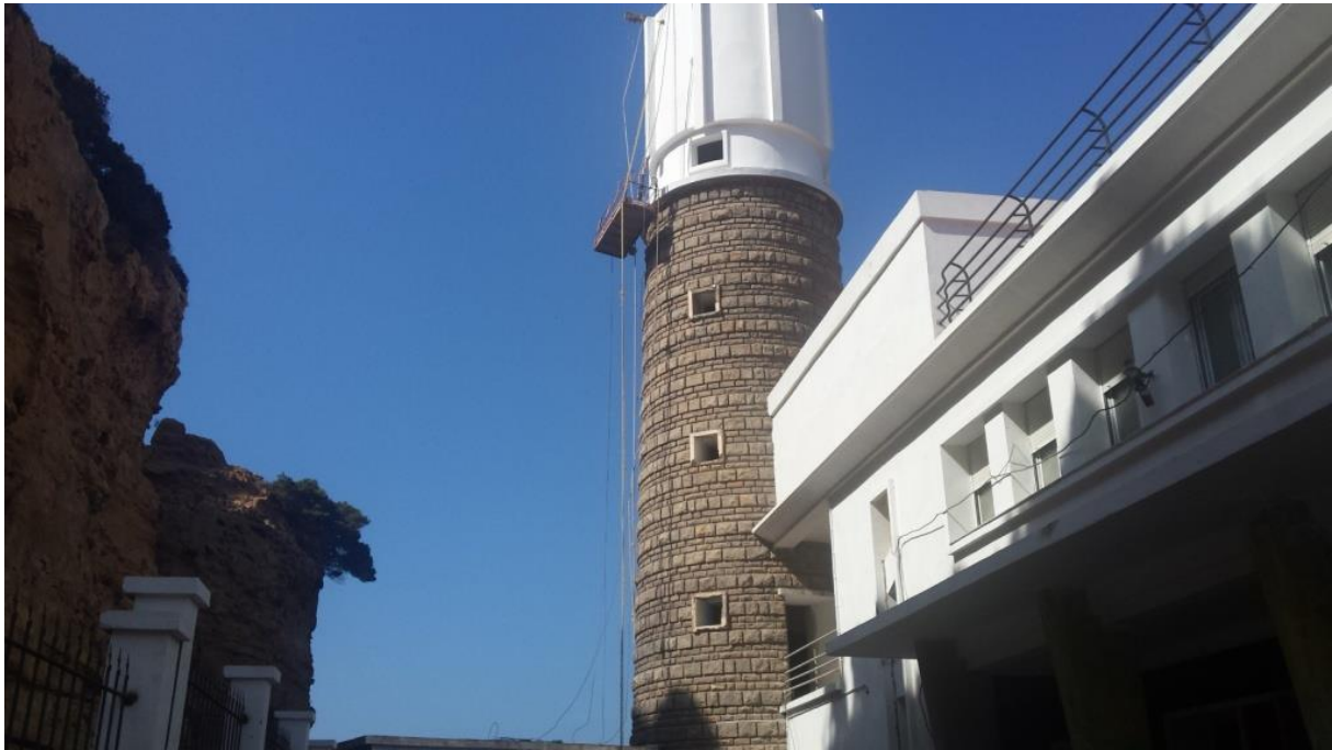
Figure 5-43 : Vue sur château d'eau
