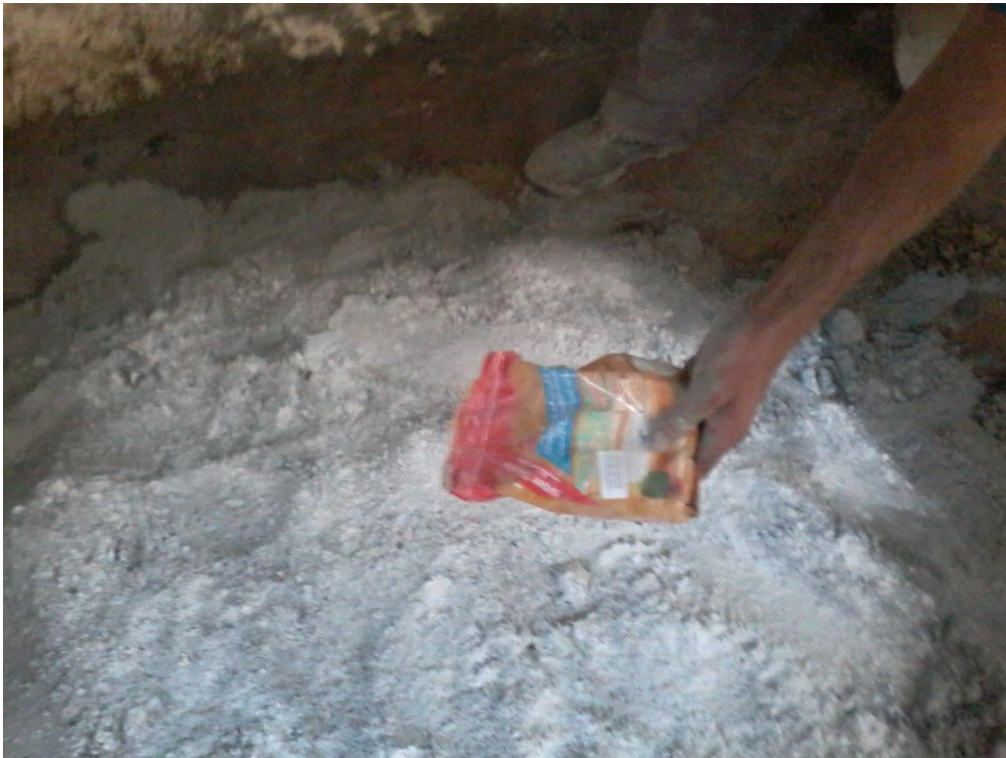
Figure 5-40: Préparation du béton de Chappe
