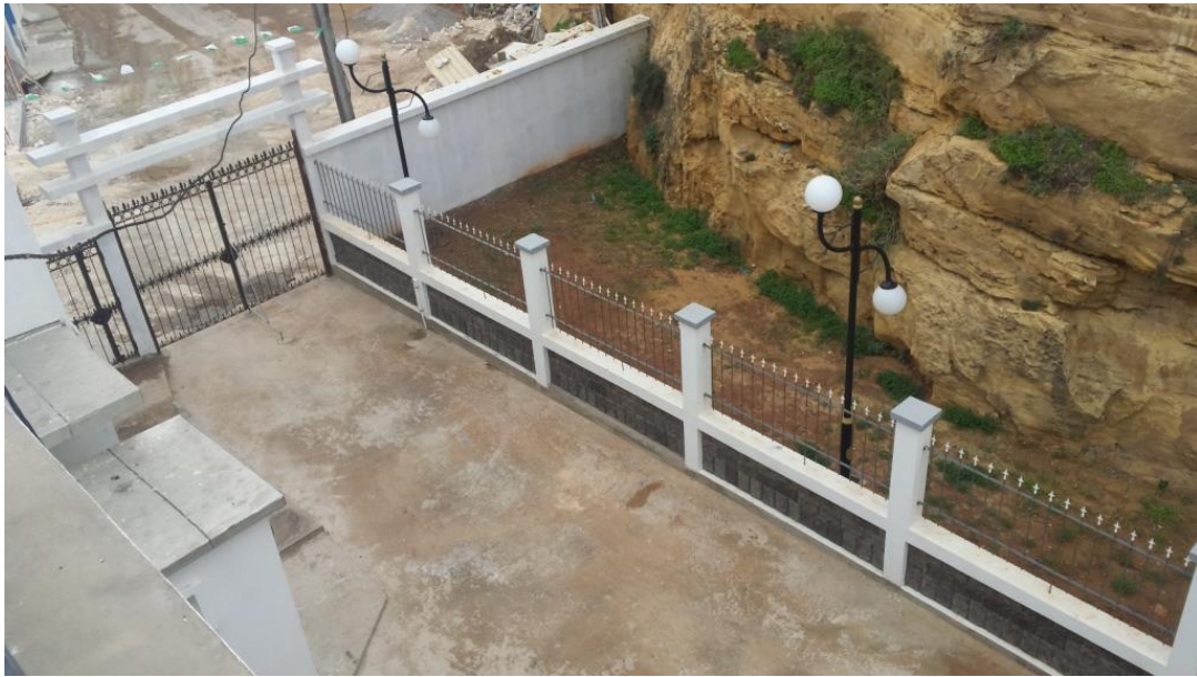
Figure 5-47 : Mur et l'entrée après travaux
