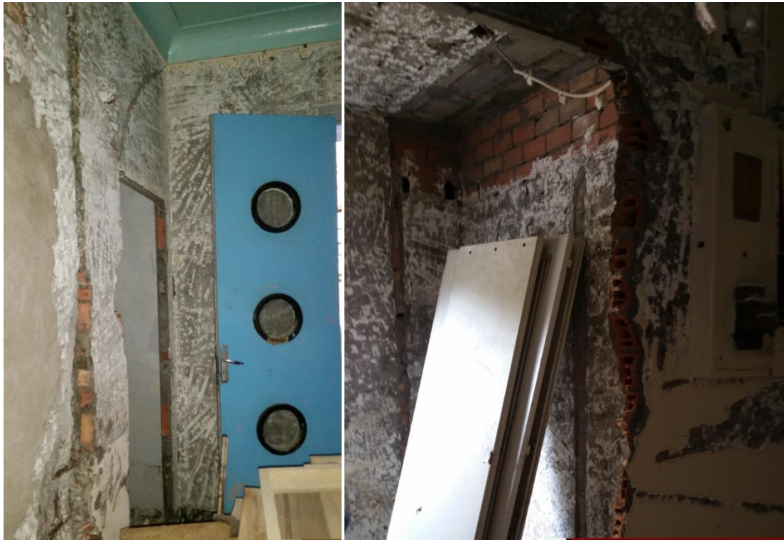
Figure 5-35 : Réparation des fissures
