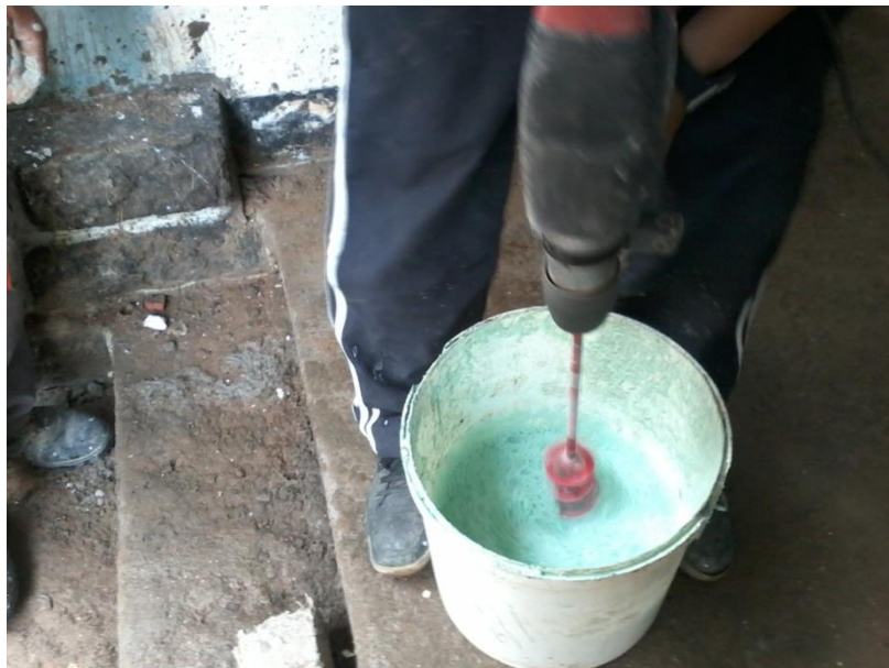
Figure 5-38 : Malaxage du mortier géo lite
