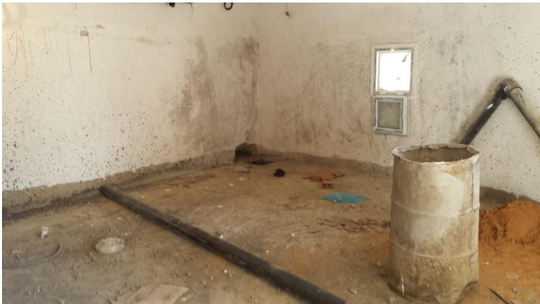
Figure 5-41 : Tuyaux d'évacuation
