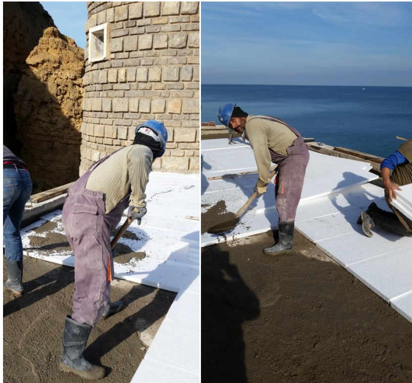
Figure 5-31 : Etanchéité terrasse
