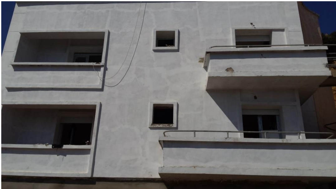
Figure 5-44 : Bâtiment annexe de l'aquarium
