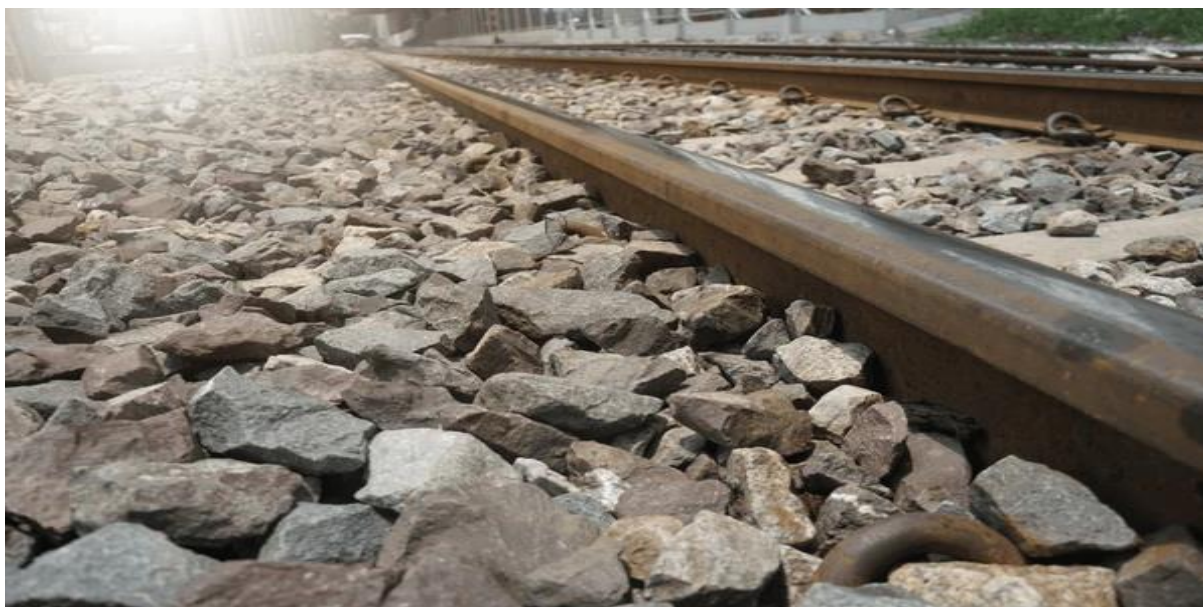
Figure 44 Superstructure Avec Mise En Place Du Ballast Autour Des Traverses
