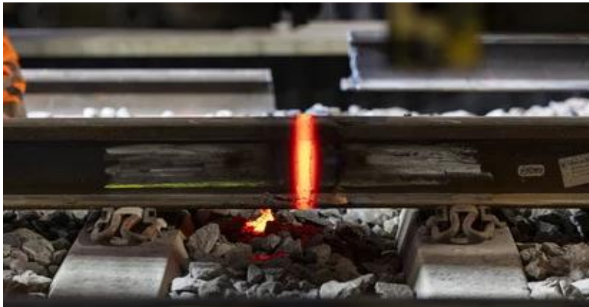
Figure 59 Joint De Soudure Par Étincelage (Flash-Butt Welding) En Phase De Refroidissement Initial Sur Voie
