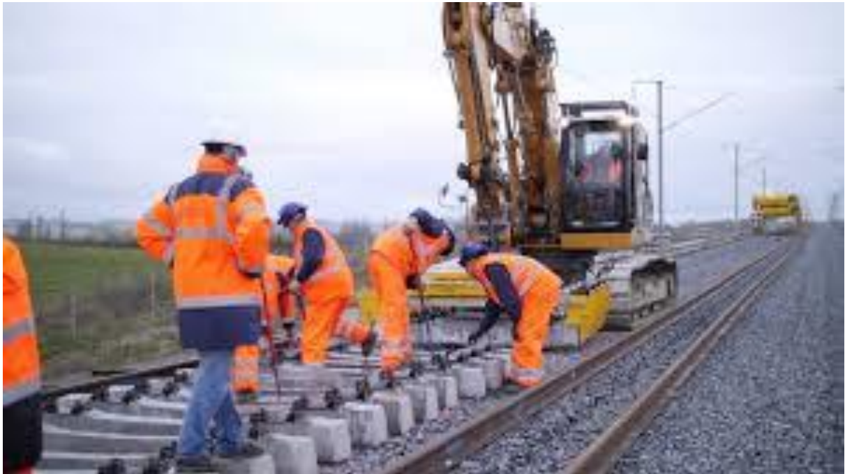
Figure 60 Chantier D'assemblage Final De La Voie Ferrée (Pose Des Traverses Et Rails En Présence De L'équipe De Supervision Et D'un Engin De Terrassement)
