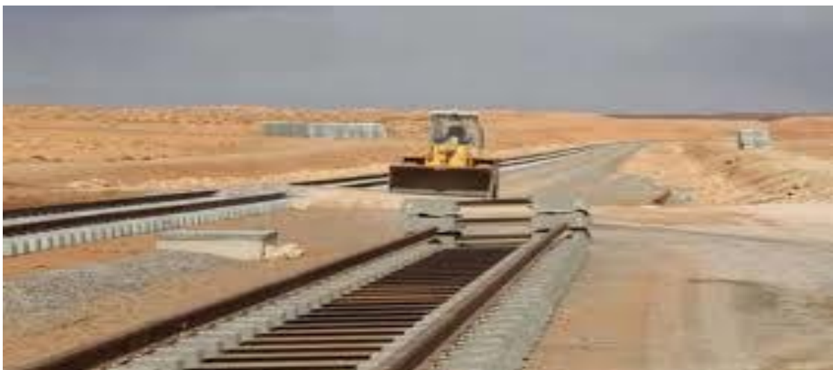
Figure 31 Vue des travaux de terrassement et de la plateforme en cours de préparation (Tronçon Tindouf)
