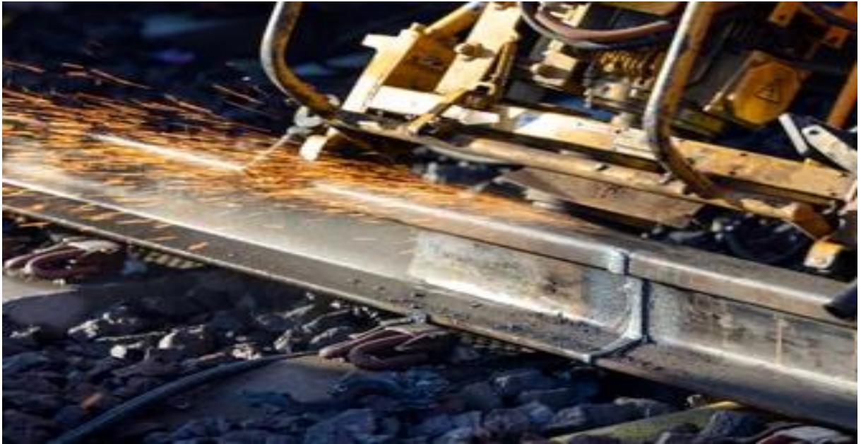
Figure 55 : Opération De Soudure Aluminothermique Réalisée In Situ Sur Voie
