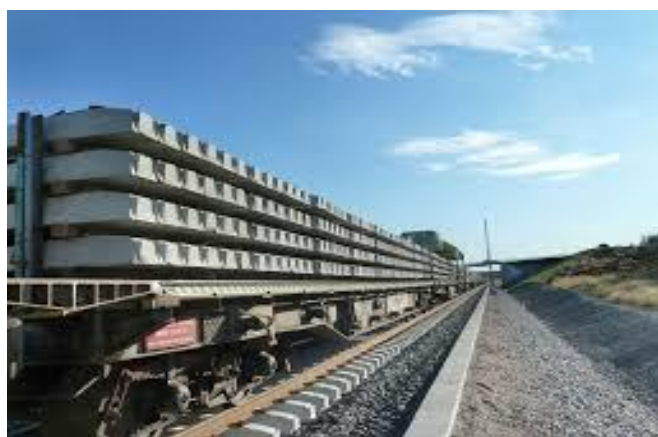
Figure 52 Transport et livraison ferroviaire de traverses en béton bi-bloc sur le site du projet
