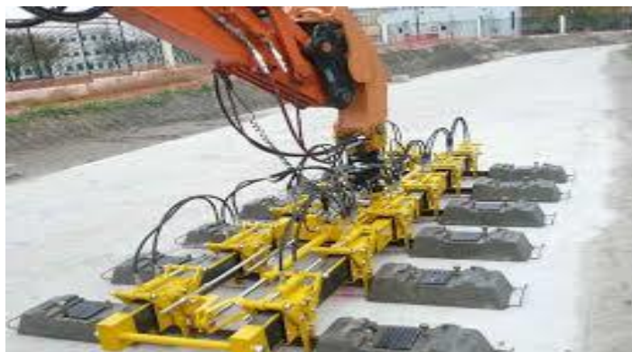
Figure 38 Pose mécanisée de traverses en béton bi-bloc à l'aide d'un portique de manutention
