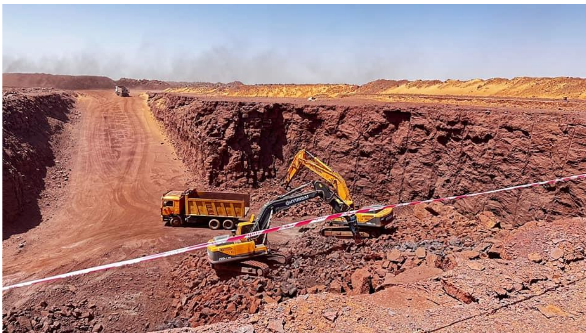
Figure 23 Vue des travaux de terrassement et d'extraction au niveau du gîte principal situé au PK 748+200.
