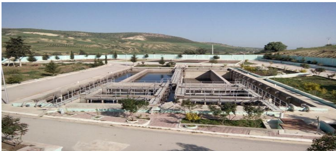
Figure 9: Bassin de traitement biologique de la station de Ain Tolba. [27]
