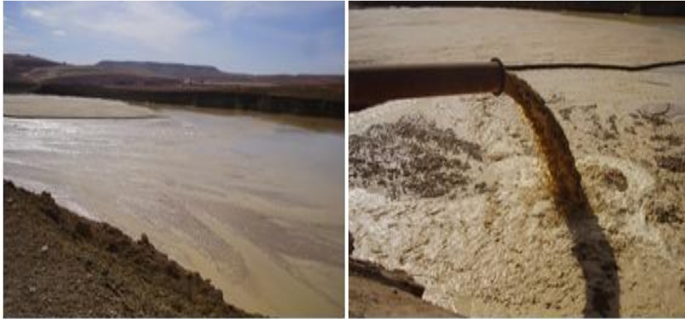
Fig.2-7 Bassin de Rejet et Capture de la Vase Draguée
