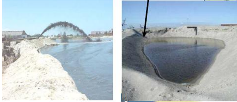
Fig.1-6 Rejet des sédiments dragués Fig.1-7. Dépôt des sédiments dragués Port Ouest de Dunkerque [Abriak, 10]
