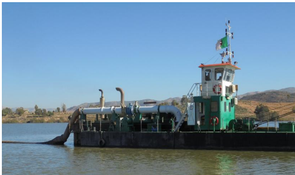
Fig.2-6 Dragage du barrage de Bou-Hanifia 2016
