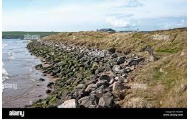
Figure 13. L'enrochement des revêtements des murs.
