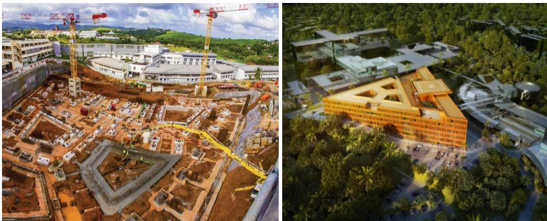
Figure I. 12: Hôpital Pierre Zobda-Quitman sur appuis parasismique
