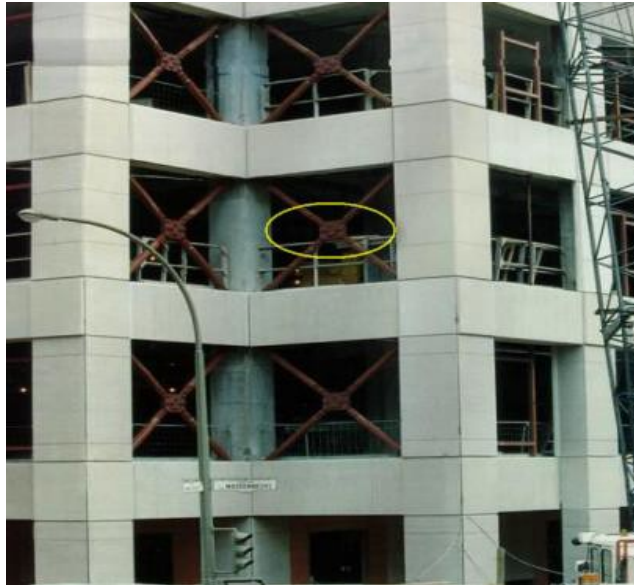
Figure I. 22:Amortisseur à friction
