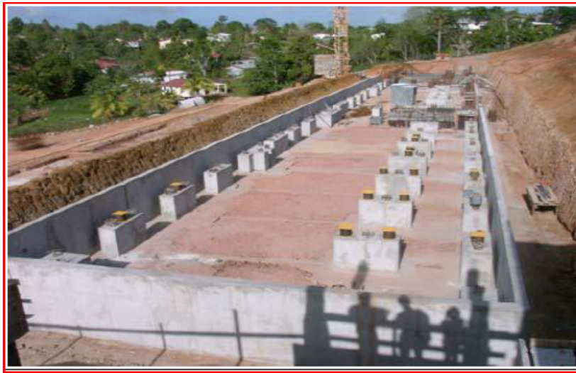
Figure I.9: Isolateurs sur les massifs de fondation.
