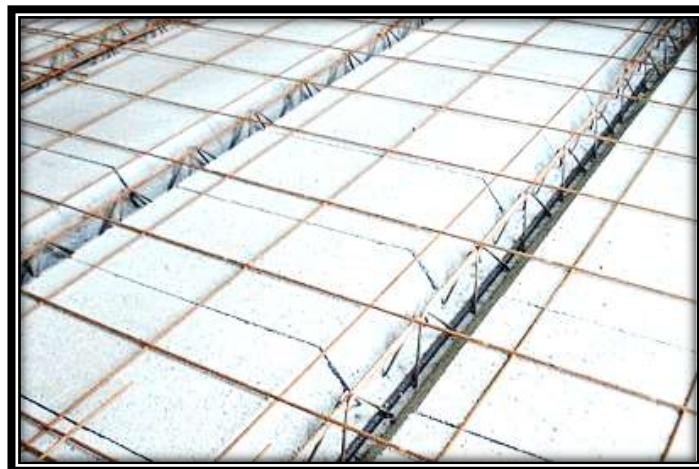
Figure IV- 22 : Disposition d'armatures de la dalle de compression
