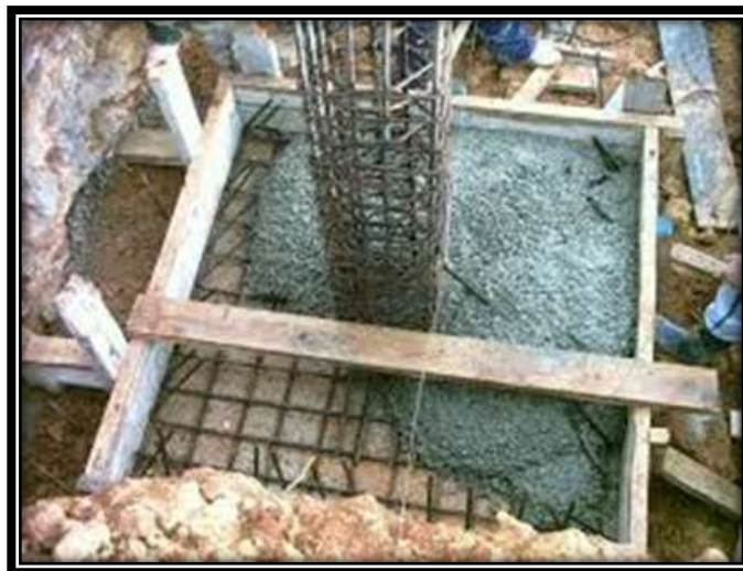
Figure V- 1 : Semelle isolé
