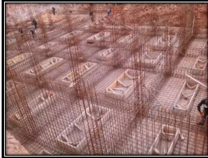
Figure V- 2 : Semelle Filante
