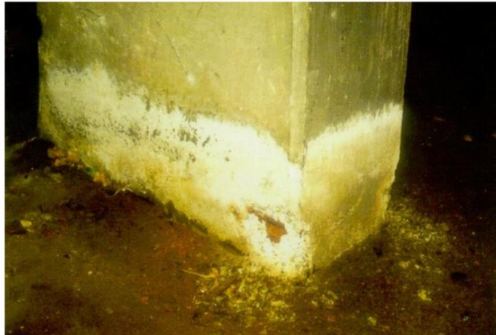
**Figure 0.8: L'attaque sulfatique externe**
