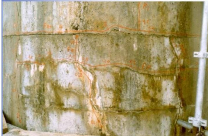
**Figure 0.7: L'attaque sulfatique interne**
