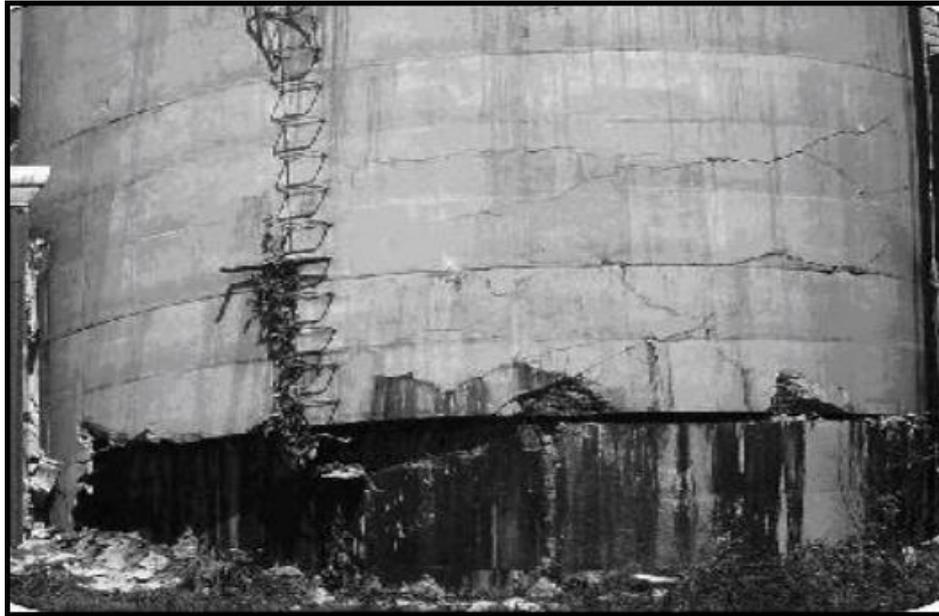
**Figure 0.2: La détérioration des silos-tours en béton due à l'attaque des acides d'ensilage.**
