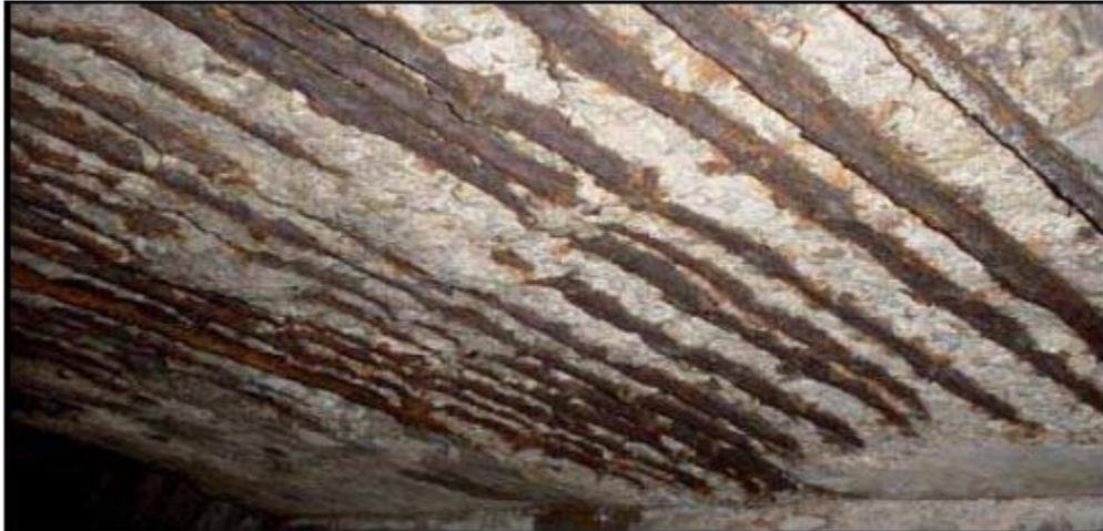
**Figure 0.3: Les attaques des sulfates sur les armatures et le béton.**
