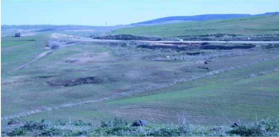
**Figure 96** : Zone de fluage au niveau du talus aval de la chaussée (Glissement au PK 24+000). (CTTP, 2014)
