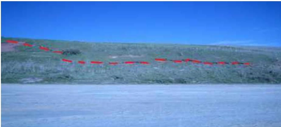
**Figure 94** : Fissures d'affaissement visible sur le remblai du côté amont. (CTTP, 2014)
