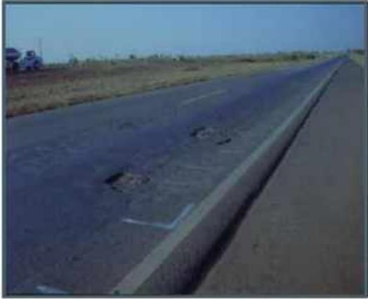
**Figure 100** : endommagements sur une chaussée
