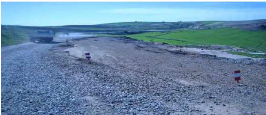
**Figure 95** : Fissures d'affaissement visible sur le remblai du côté aval (Glissement au PK 24+000). (CTTP, 2014)
