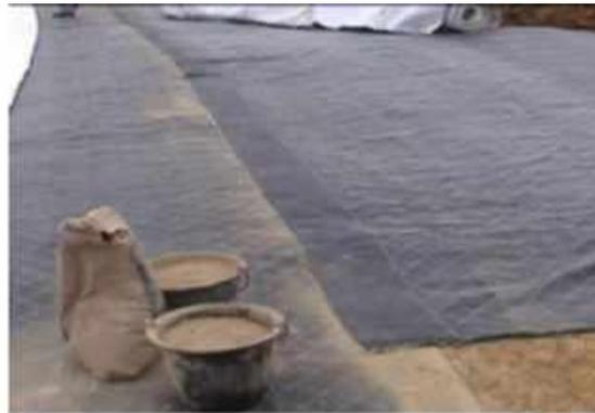
**Figure 63:** image d'un géo synthétique bentonitique
