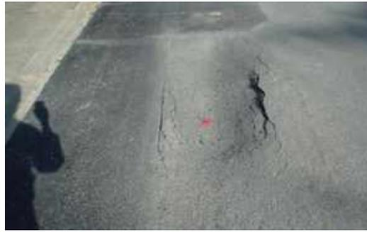
f-Affaissement de chaussée suivi d'une dégradation du revêtement
