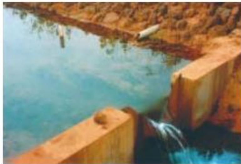
Figure 34 : Seuil calibré triangulaire pour mesure des débits, équipé de son limnimétrie amont. [25]
