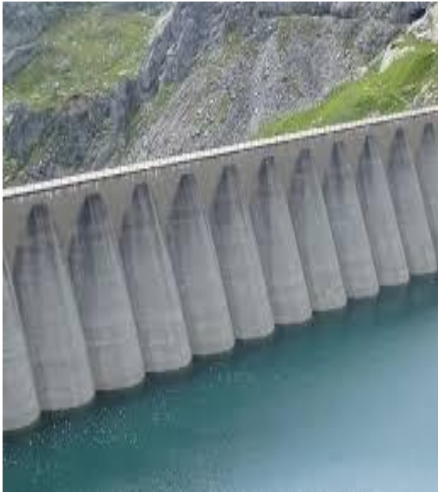
Figure 3 : Un barrage à contrefort
