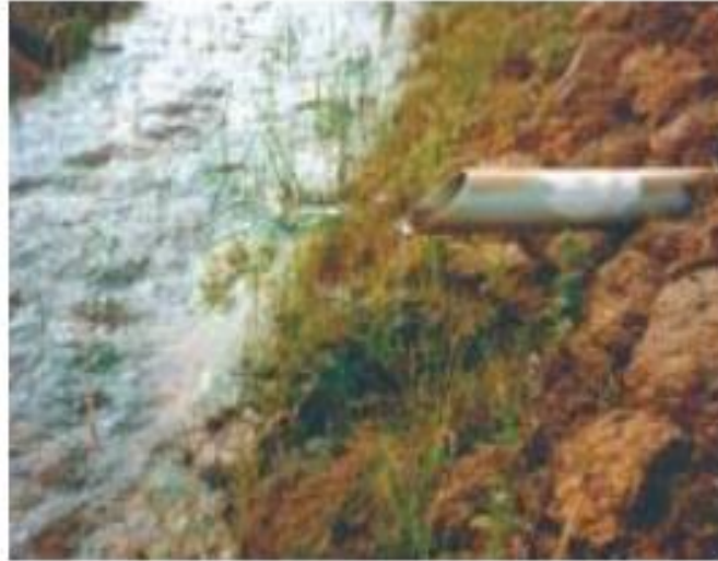
Figure 33 : Exutoire d'un drain permettant des mesures par emportement depuis le fossé du pied. [25]
