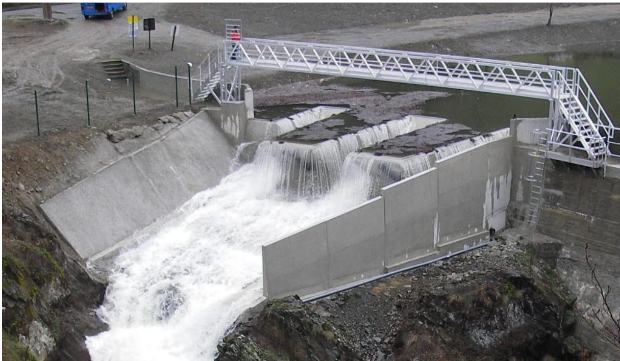
Figure 8 : Evacuateur de crue
