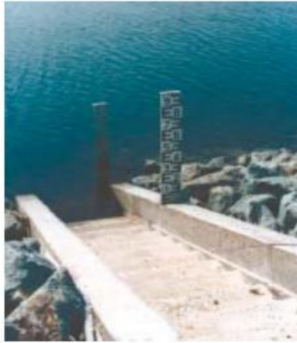
Figure 32 : Echelle limnimétrie posée sur le parement amont. [25]
