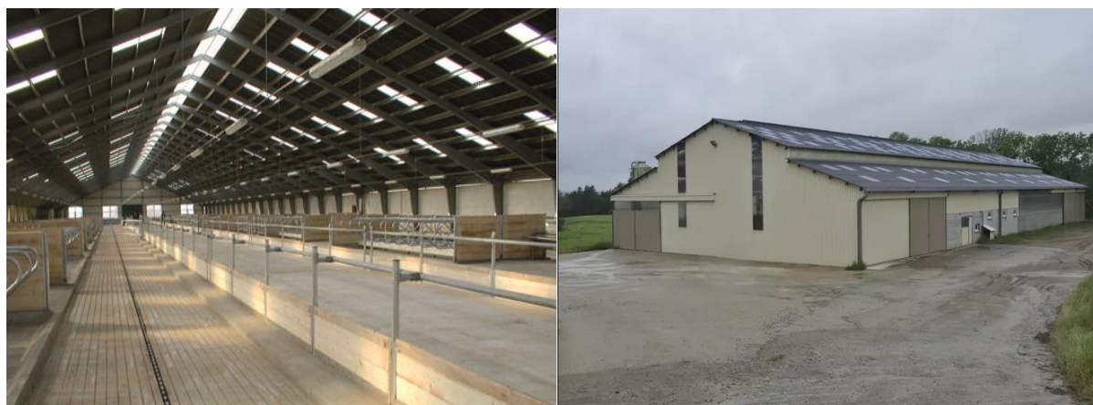
Fig.2.10 : Exemple de bâtiment d'élevage bovin (image Google).
