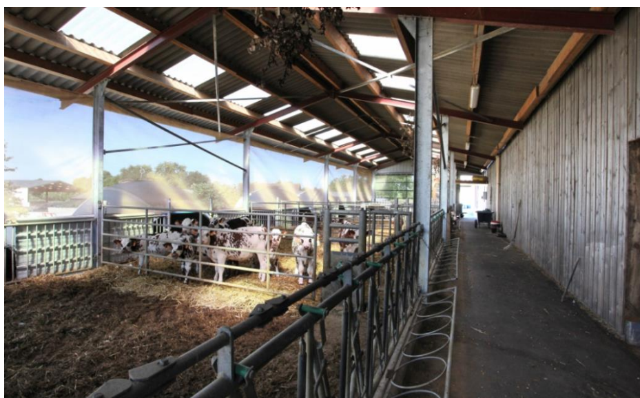
Fig.2.16 : Ventilation naturelle des bâtiments d'élevage
