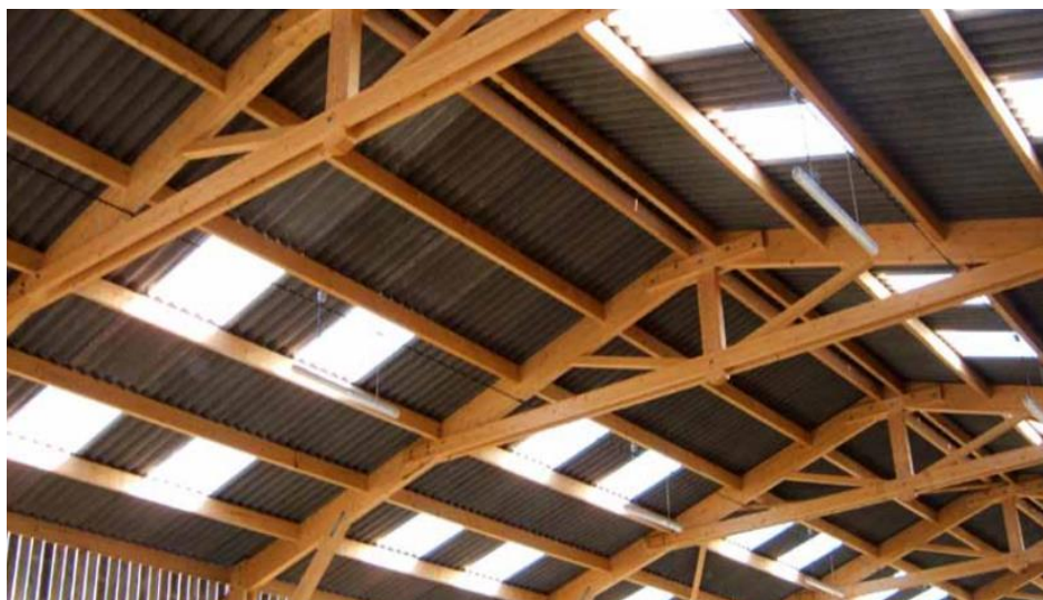
Fig.2.17 : Éclairage en bâtiments d'élevage
