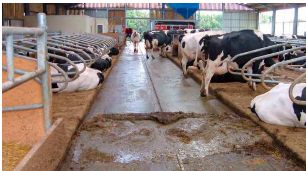
Fig.2.18 : Canal à lisier en bout de bâtiment
