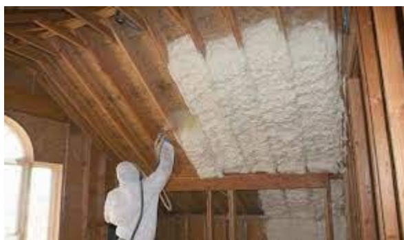
Figure 21 : L'injection de Mousse Isolante
