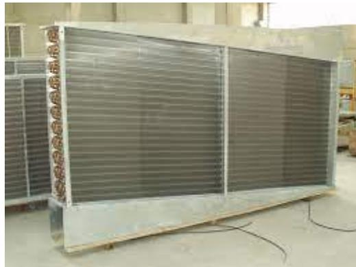
**Figure 4 :l'échangeur de chaleur tubulaire Caloduc.**
