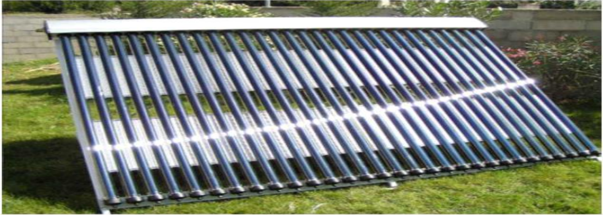
Figure II. 8: Capteur solaire a tube sous vide. [17]
