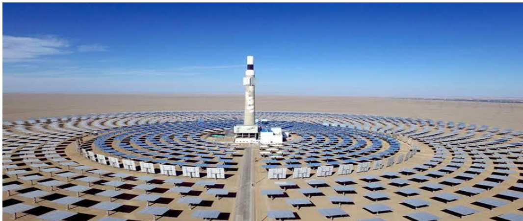
Figure I. 3: Les centrales solaires thermiques. [9]
