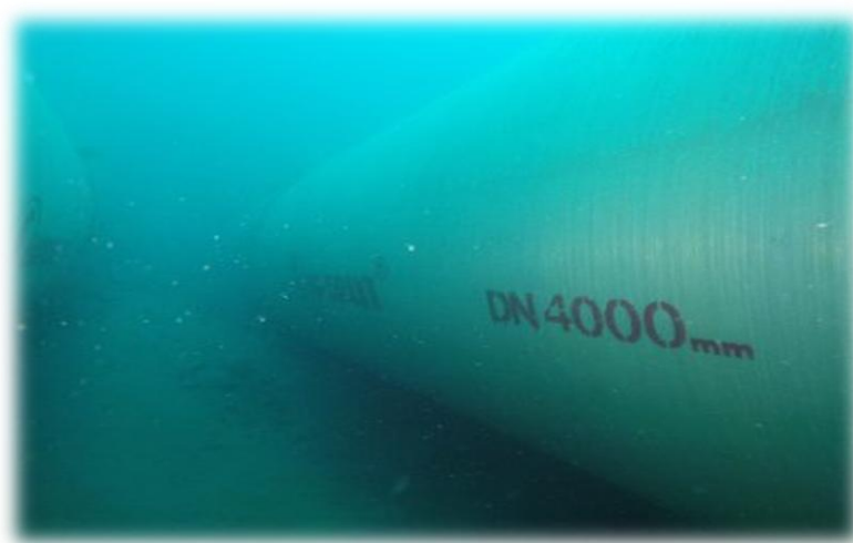
Figure (II.8): Tuyau de captage de l'eau de mer. [61]
